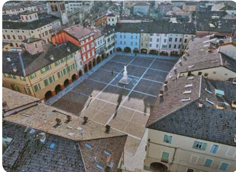
PROGETTO | PROJECT Riqualificazione Piazza Spallanzani Renovation Piazza Spallanzani Scandiano (RE) PROGETTISTI | DESIGN TEAM Ing. Giampaolo Bendinelli Arch. Wainer Zannoni
