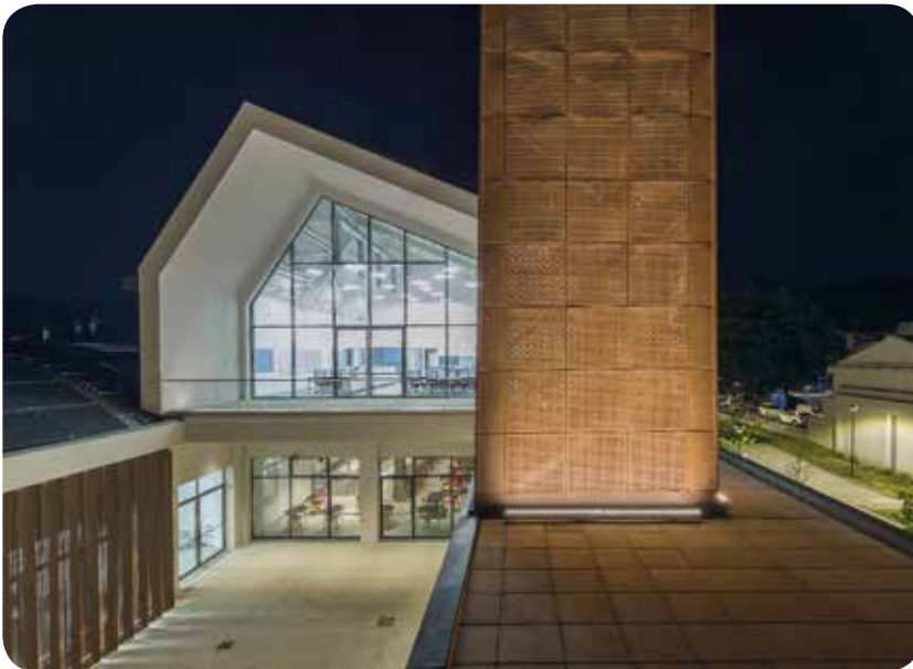
PROGETTO | PROJECT Prismalab Comune di Prato (PO) PROGETTISTI | DESIGN TEAM Arch. Massimo Fabbri, Arch. Michela Brachi, Ing. Alessandro Pazzagli
