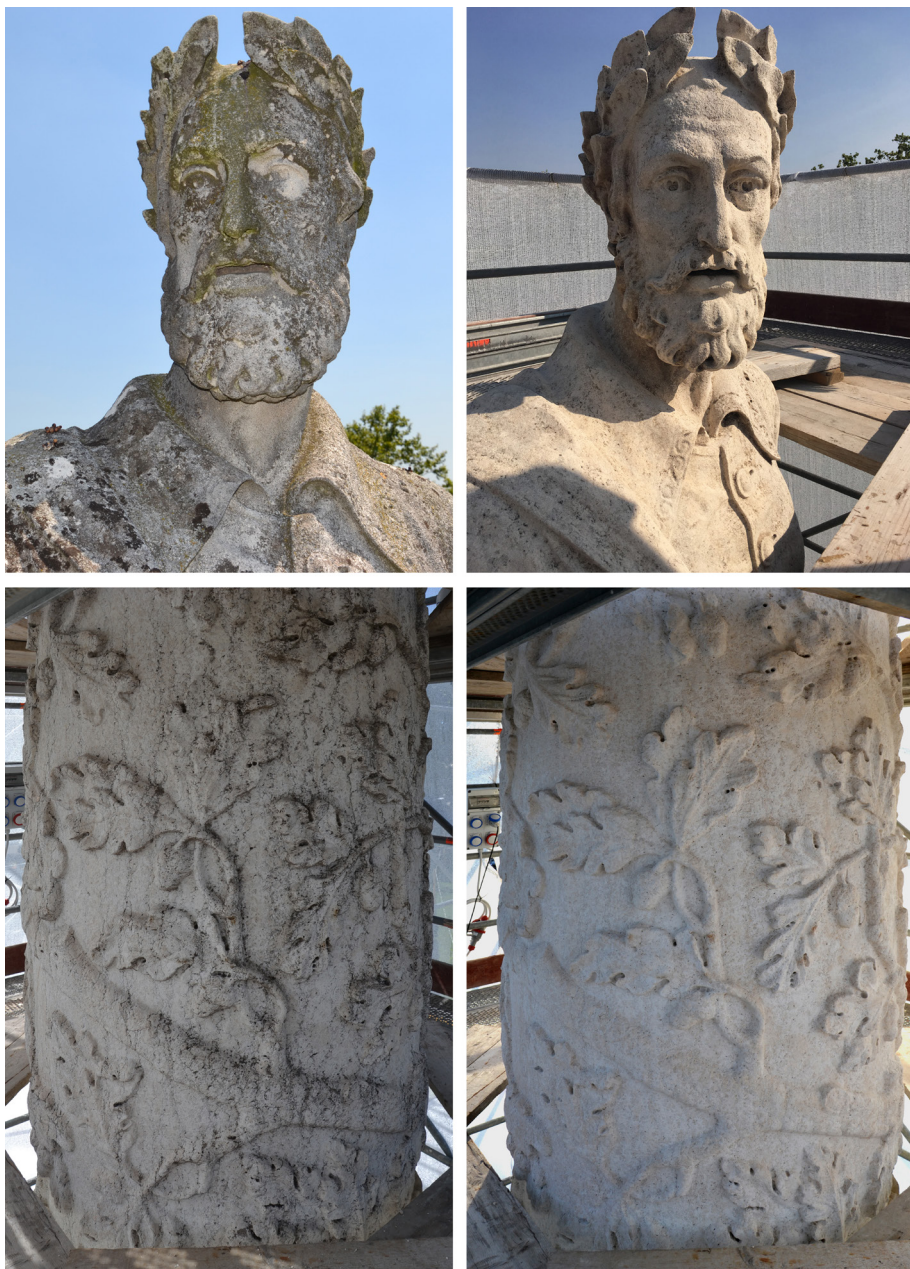
8. Statua di Ariosto e fusto della colonna prima e dopo le operazioni di pulitura.
