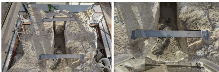
7 Nuove àrpesi (grappe) poste a collegamento dei vari blocchi del capitello in acciaio duplex.
