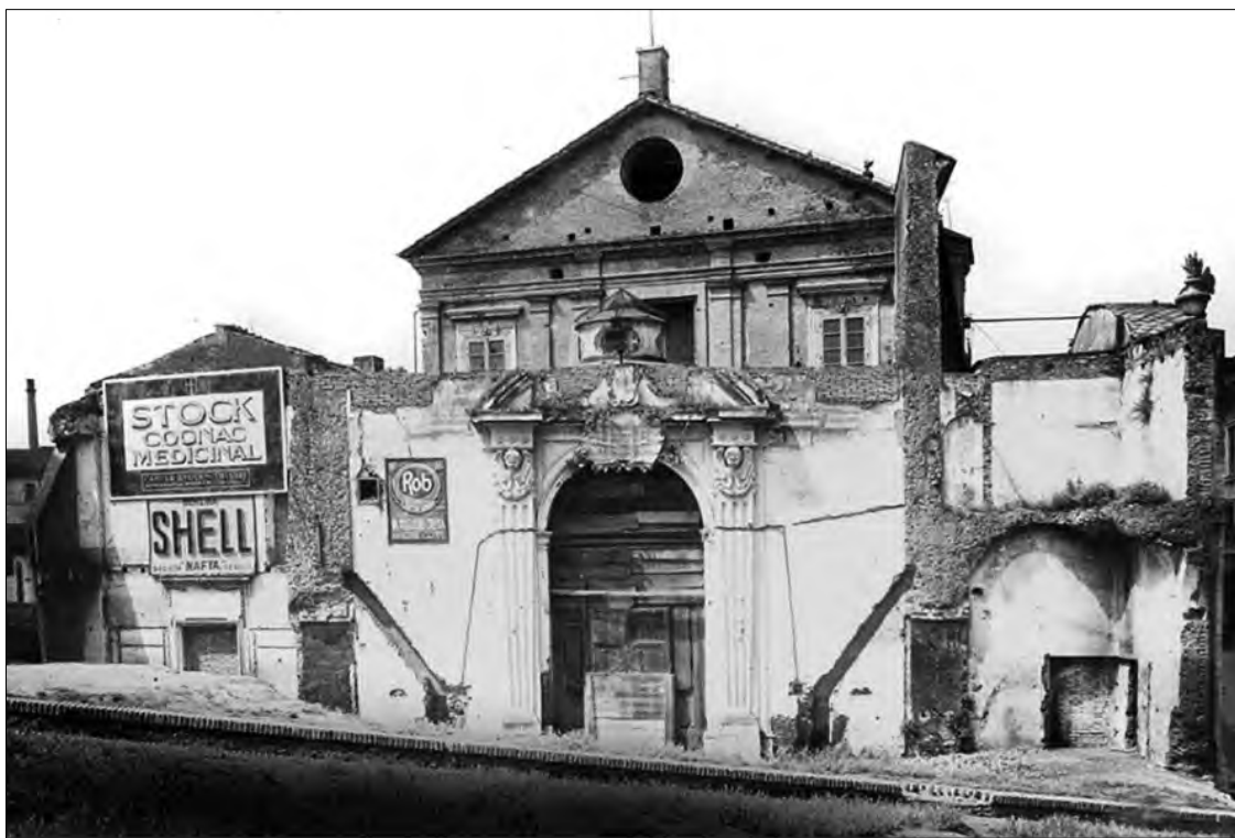
Fig.4- Le demolizioni portano alla luce il prospetto quattrocentesco (tratto dal sito https://www.info.roma.it/foto_dettaglio.asp?ID_immagini=7710 , visionato in data 22 febbraio 2024).
