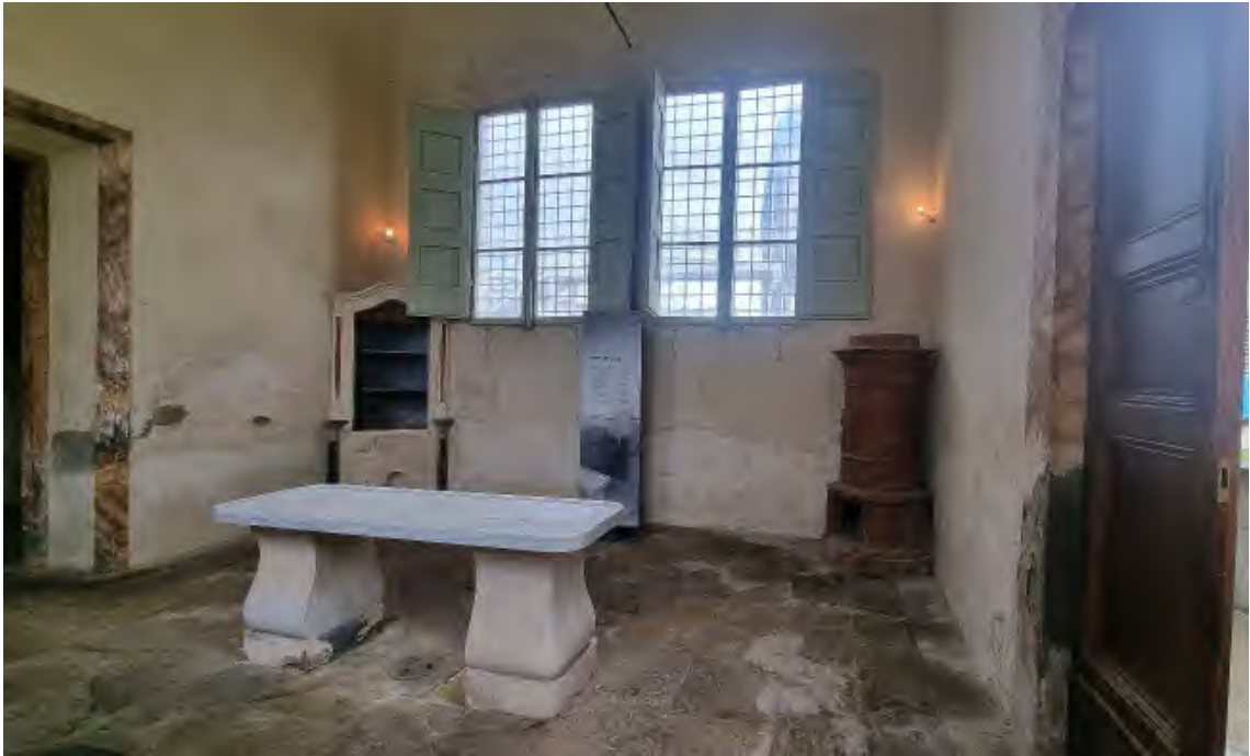
Fig. 3 – Interno della prima sala-anticamera riscaldata dalla stufa in terracotta nell'angolo e, al centro, tavolo di marmo con lo scolatoio e angoliera in muratura nell'angolo opposto (Beatrice Messeri).
