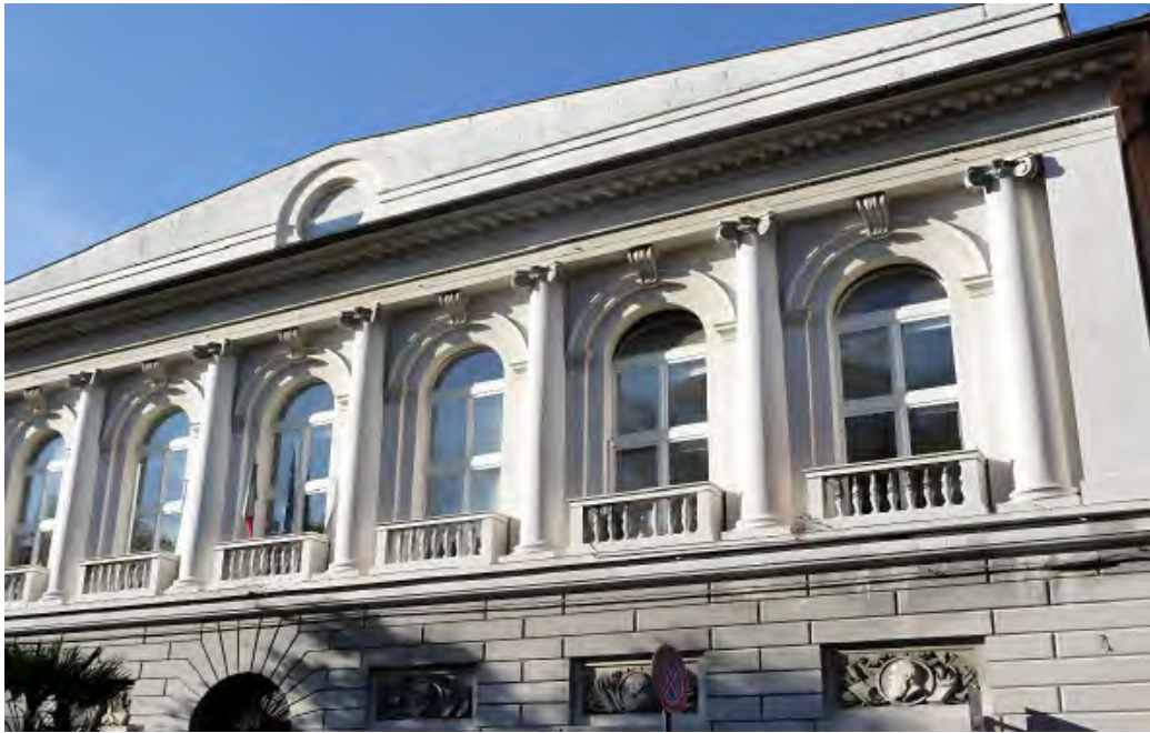
Fig. 2 - L'edificio in stile neoclassico (costruito tra il 1843 e il 1846), ospitava il "Regio Teatro Anatomico" di Genova, oggi sede del tribunale per i Minorenni di Genova in Viale IV Novembre.
