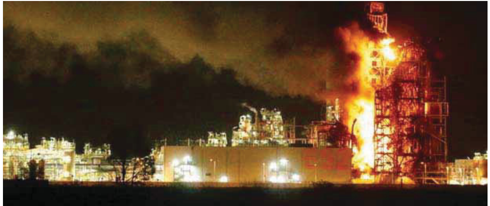
Fig. 50 ENI Sannazzaro de Burgondi oil refinery (source: www.ilgiorno.it/pavia )
