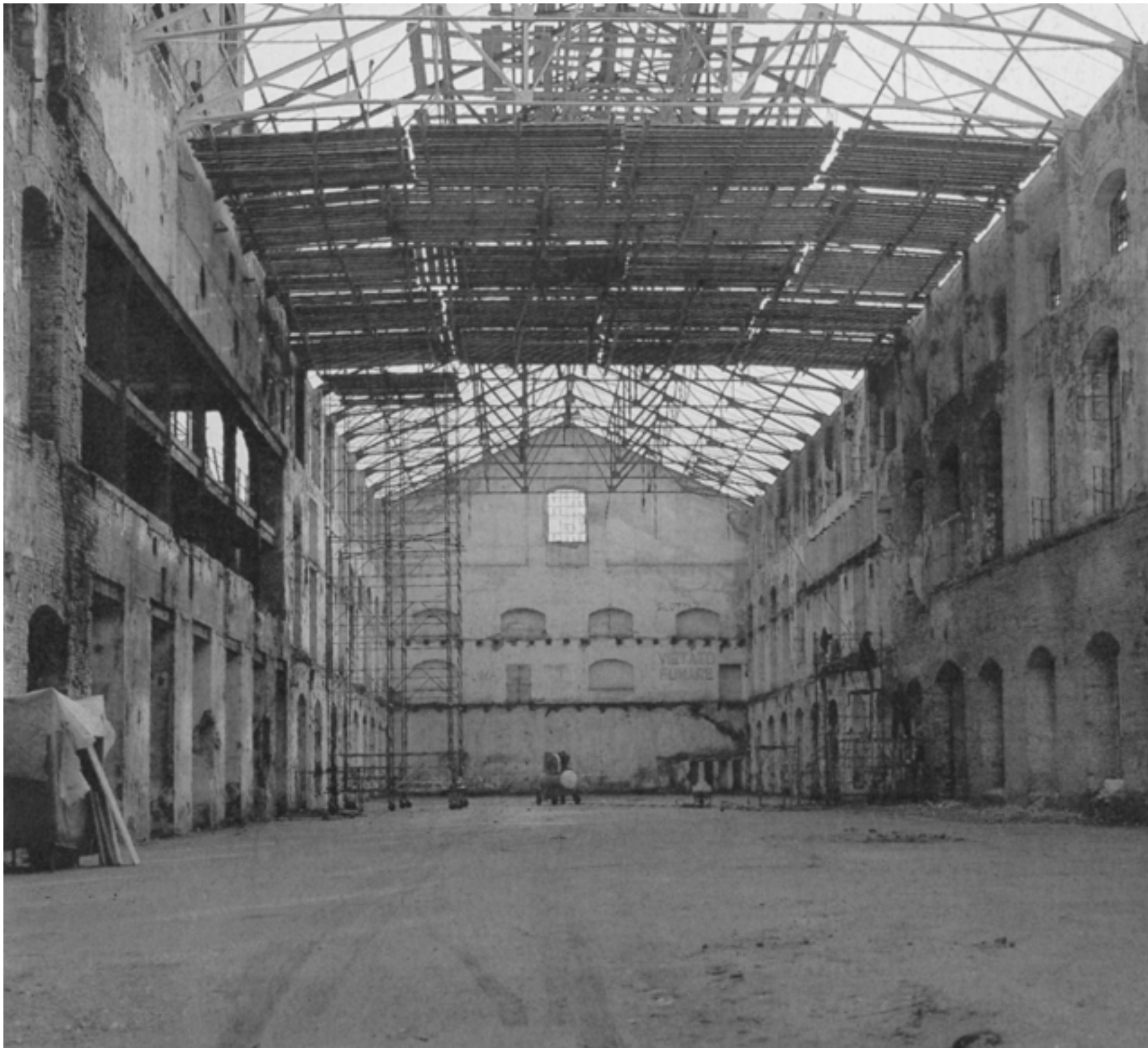
255. Lo Zuccherificio ex Agricolo Ferrarese poi Eridania durante i lavori di ristrutturazione del progetto F.R.I.E.T. (R.R., 1986) Roda R., Guerzoni G. (curatori), Il tempo delle ciminiere [...], parte prima 1800-1920, Padova: Interbooks 1992
