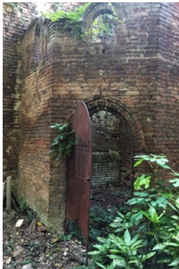
357. Probabile struttura dell'antica colombaia Giardino di Palazzo Contughi-Gulinelli (2018) Foto di Cristina Baldi
