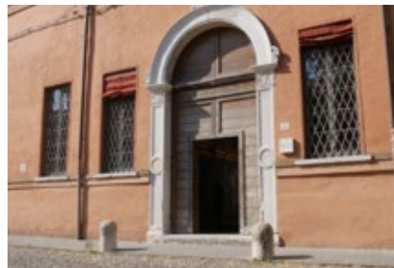
193. Portale di ingresso, Palazzo Tassoni Estense Dipartimento di Architettura (2019) Foto di Sara Guberti
