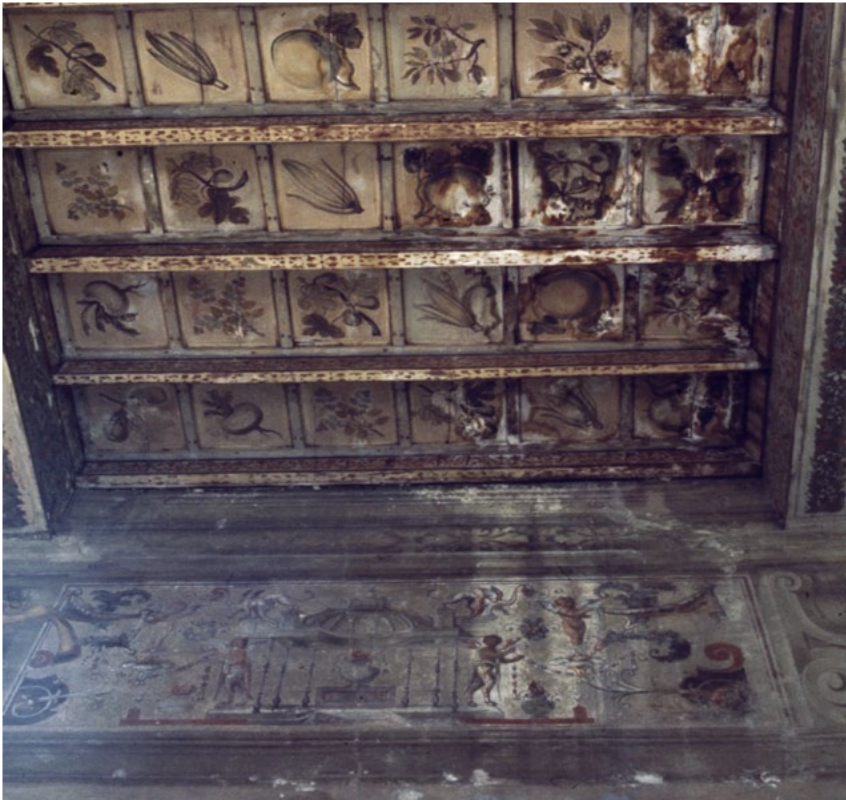
296. Soffitto ligneo del salone, piano nobile, Palazzo Tassoni-Mirogli (diapositiva, 01/04/1974 post - 31/08/1974 ante) Fondo Paolo Monti, Civico Archivio Fotografico, Milano (in deposito da Fondazione Beic)
