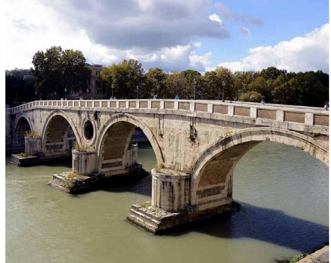
Ponte Sisto in Roma, la reintegrazione del parapetto in forme semplificate ha permesso il pieno recupero della forma dello storico ponte
