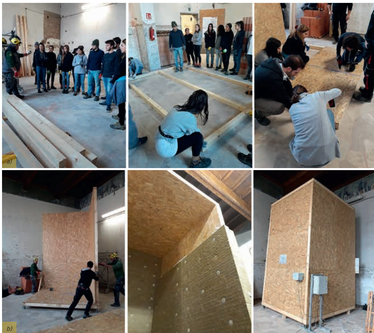
Figura 2 – SCHOOLab. Dal momento che il principale obiettivo operativo della ricerca è l'analisi termo-igrometrica delle soluzioni di retrofit per l'efficientamento dell'involucro degli edifici storici, il living lab onsite è stato inserito in una delle grandi stanze non ancora restaurate di Palazzo Tassoni Estense a Ferrara. Si è deciso di costruire una camera climatica (Hot Box) in situ con l'obiettivo di migliorare la sostenibilità del sistema/processo di monitoraggio nel suo complesso: invece di riscaldare l'intera stanza dove vengono effettuati i test sui sistemi di isolamento, questa grande scatola permette di risparmiare molta energia, trattandosi di un esperimento a lungo termine, e anche di meglio controllare la stabilità della temperatura e dell'umidità relativa "interna".
