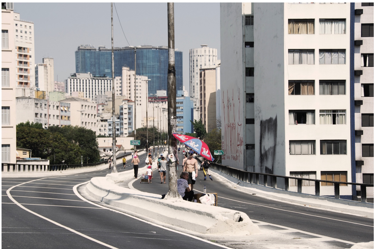
Figura 2 | Uso informale del viadotto. Fonte: Abbruzzese L. (crediti fotografici)
