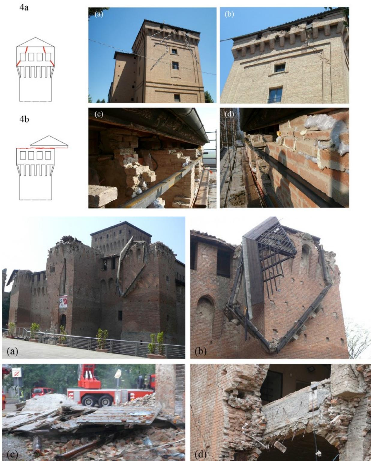
Figura 184: Interventi in cemento armato: (a), (b) Cordolo e particolare del cordolo penzolante nella rocca di S.Felice sul Panaro; (c) Soletta in copertura nella rocca di Finale Emilia; (d) Sfilamento delle armature di ancoraggio.
