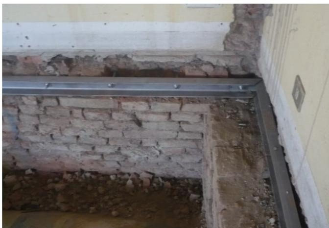
Figura 81: Particolare cerchiatura del primo solaio mediante UPN 80
