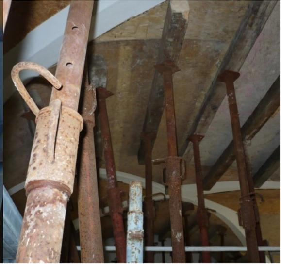
Figura 80: Puntellatura di sostegno delle volte del primo solaio
