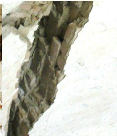
Figura 186: Spessore e tessitura della volta
