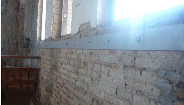
Figura 89: Piatti metallici alla quota di bancale delle aperture
