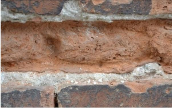
Figura 100: Malta bastarda con un alto tenore cementizio, buone caratteristiche
