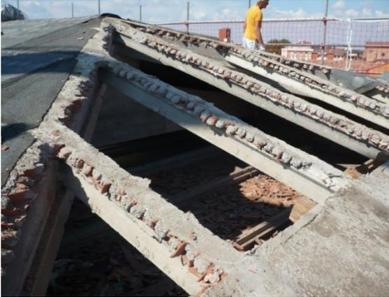
Figura 84: Copertura in latero cemento con travi in c.a.
