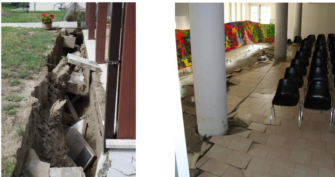
Figura 6: Effetti della liquefazione
