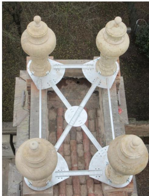
Figura 167: Sistema di isolamento progettato per i pinnacoli laterali
