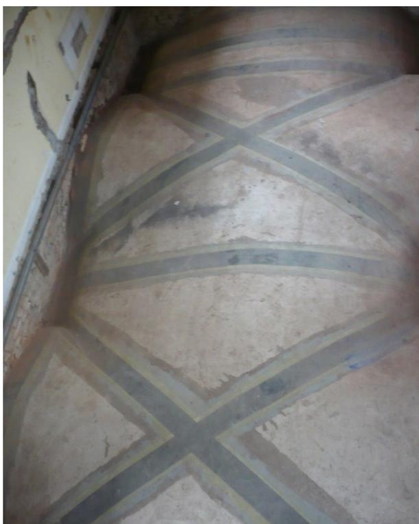
Figura 82: Consolidamento delle volte mediante fibre di vetro e di carbonio all'estradosso
