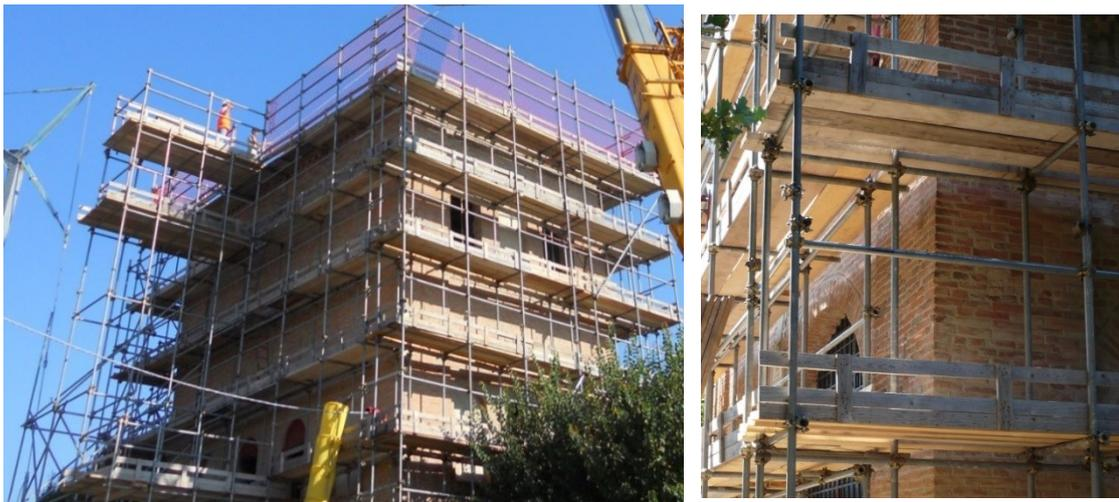
Figura 78: Particolare ponteggi di cerchiatura dell'edificio
