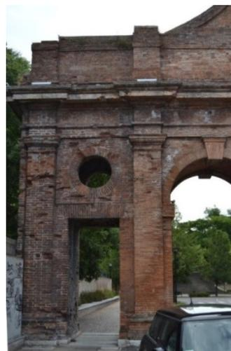
Figura 99: Degrado degli archi laterali
