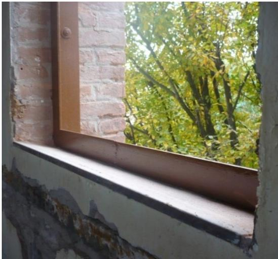
Figura 91: Cerchiatura delle aperture
