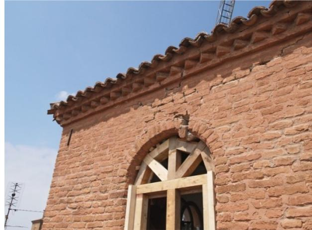
Figura 218: Danneggiamento sopra le aperture
