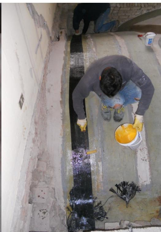
Figura 83: Particolare posa in opera delle fibre di carbonio
