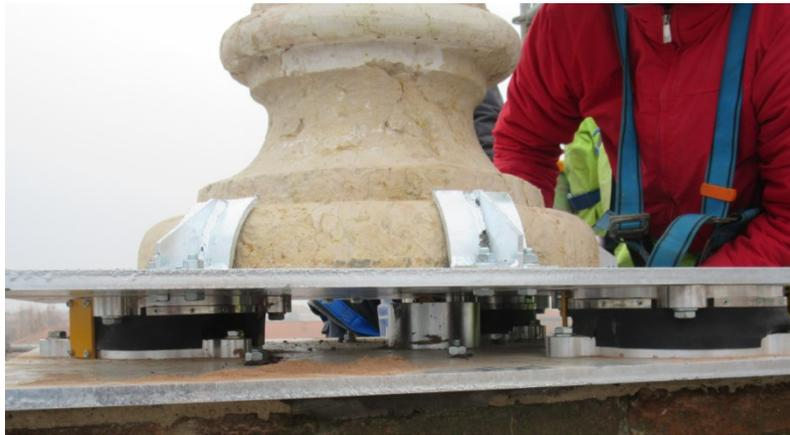
Figura 166: Sistema di isolamento progettato per i pinnacoli centrali
