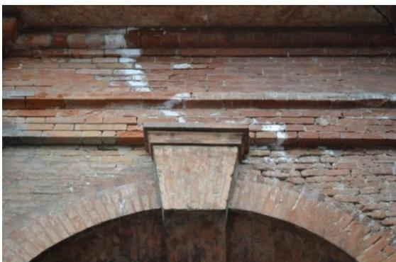
Figura 98: Particolare dell'arco mostrante lo stato di degrado
