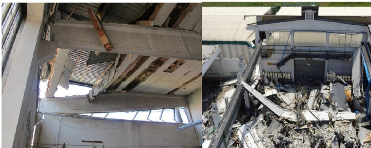
Figura 7: Danni alle strutture prefabbricate industriali
