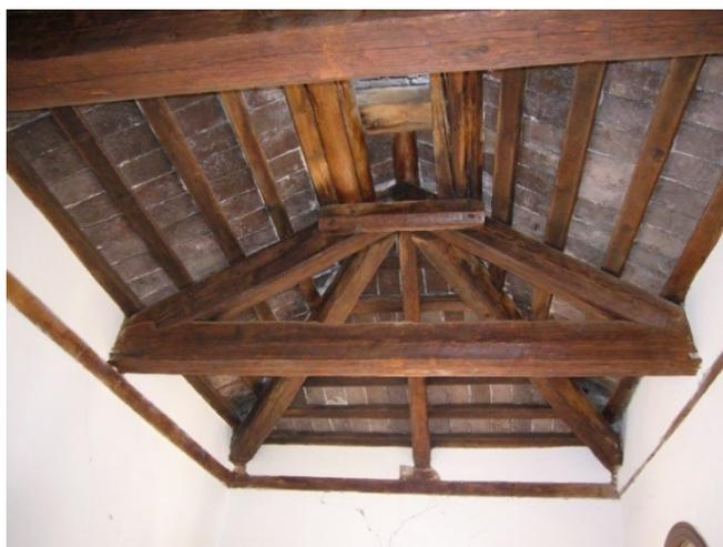
Figura 206: Solaio di copertura della torretta
