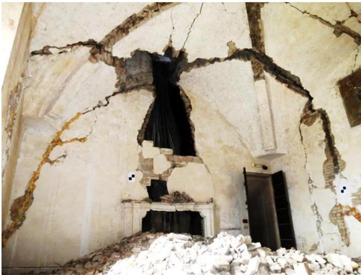
Figura 185: Danneggiamento della volta
