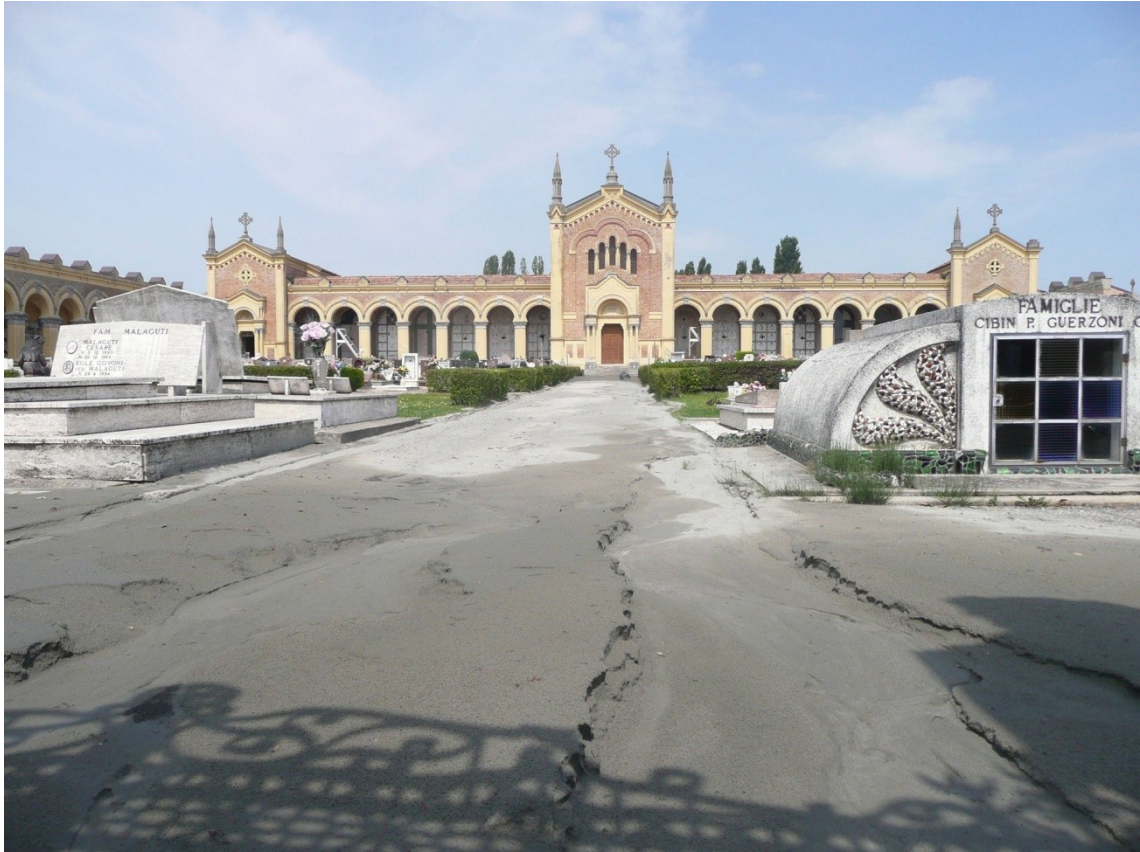
Figura 2.34 - Diffusi effetti di liquefazione nel Cimitero di Sant'Agostino.
