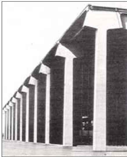
1.7 Angelo Mangiarotti, struttura industriale prefabbricata, Monza, 1965
