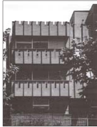
1.8 Marco Zanuso, fabbrica Olivetti in Argentina, foto di cantiere con l'elemento trave/pilastro gettato in opera
