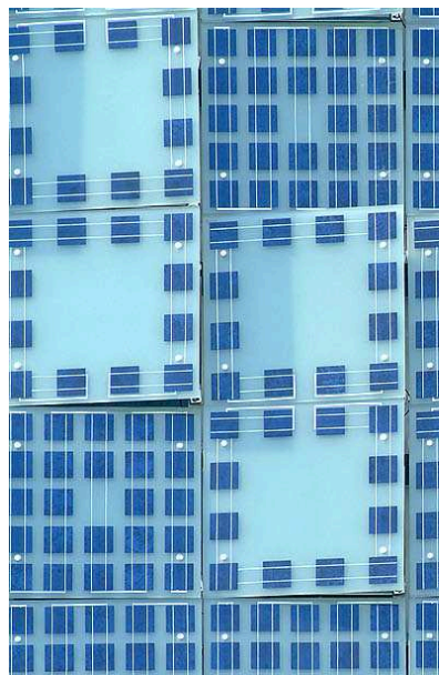
Fig. 3.3 Moduli fotovoltaici per la parete dell'edificio Green Pix , Simone Giostra & Partners Architects, Beijing China, Giochi Olimpici 2008.
