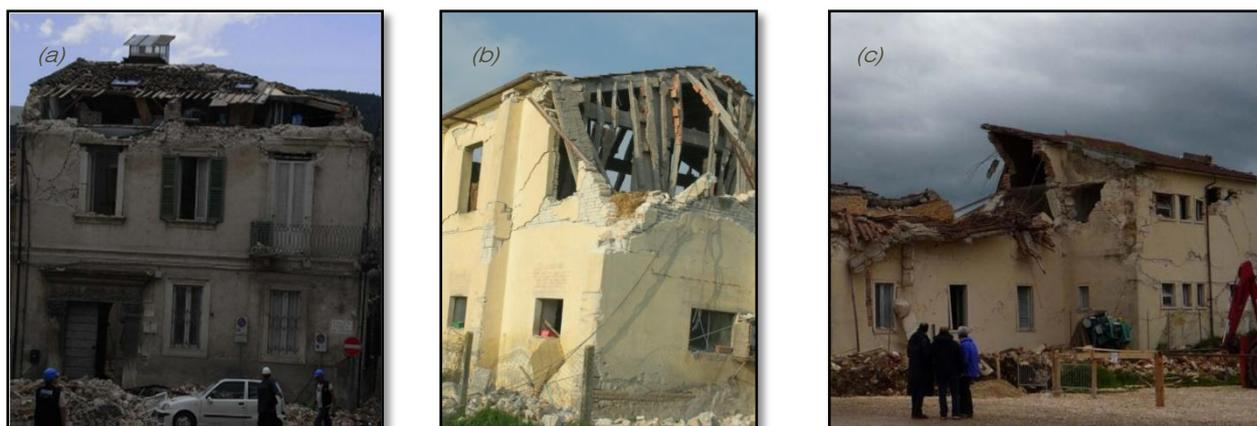
*Figura 1 – Esempi di collasso strutturale della struttura di copertura di edifici in muratura avvenuti durante il terremoto dell'Aquila il 6 aprile 2009*
