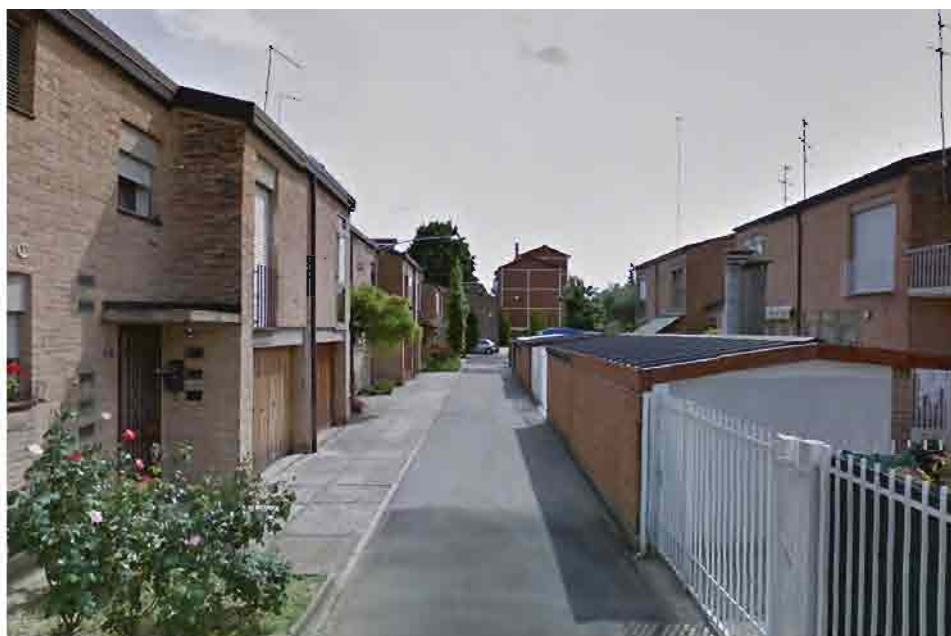
52 Immagine delle case a schiera riprese percorrendo Via Filiasi in direzione sud.
