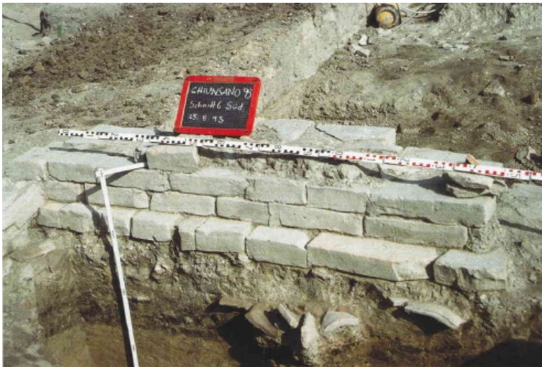
Fig. 28 – Gaiba (RO), Chiunsano. Scavi dell’Università di Bochum. Muro dell’edificio sud-occidentale costruito con materiale di recupero, attribuito alla seconda fase (da Büsing-Kolbe, Büsing 2002),
