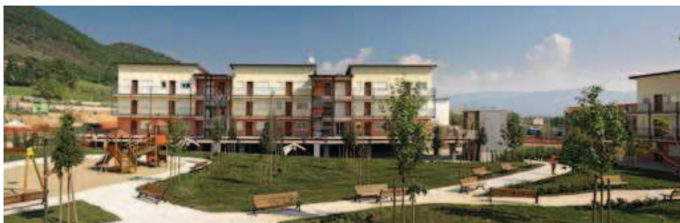
Figure 1.6 e 1.7_Cese di Preturo: 100 abitazioni consegnate dopo soli 67 giorni lavorativi, 8in meno rispetto ai tempi preventivati per la cantierizzazione.
