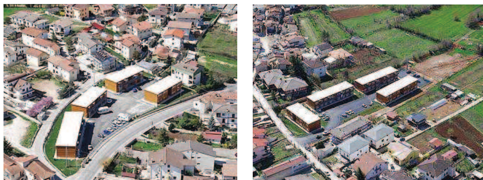
Figure 1.9 e 1.10_ Esempi di M.A.P. nelle località di Arischia e Cansatessa, presso L'Aquila: nel complesso sono circa 40.000 m 3 di cubatura totale del progetto, con 220 unità abitative di varie dimensioni, di cui 10 per portatori di handicap.
