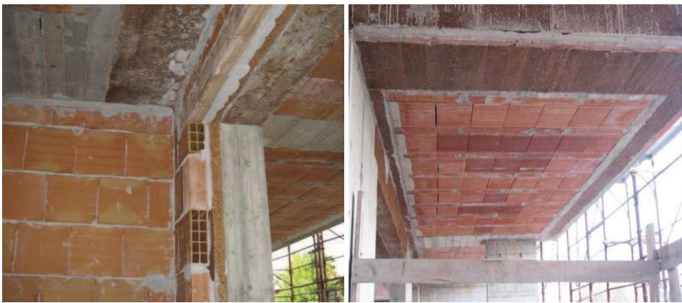
Figura 6.1 e 6.2 _Nodo chiusura - infisso - sbalzo: in questo caso si è provveduto alla realizzazione di una chiusura verticale stratificata, con interposizione di pannelli in sughero biondo naturale compresso; lo stesso materiale viene fatto svoltare anche su tutta la superficie dello sbalzo.
