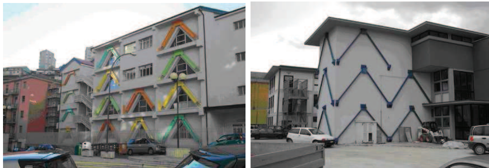
Foto 3.8 A sinistra, scuola Domiziano Viola a Potenza, e a destra, scuola Gentile Fermi di Fabriano: esempi di applicazione della dissipazione d'energia (dissipatori elastoplastici nel primo caso, viscoelastici nel secondo)
