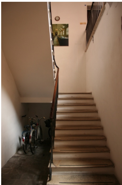
Il corpo scala è il tipico vano verso cui si rivolgono le pareti divisorie tra ambienti interni.
