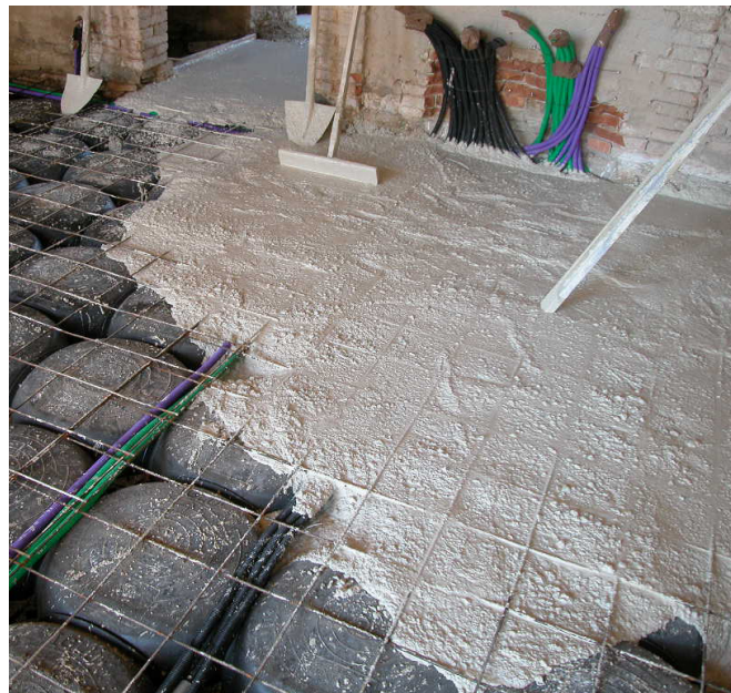
Inserimento di struttura per il distacco del solaio a terra in un contesto di edilizia pre-industriale.
