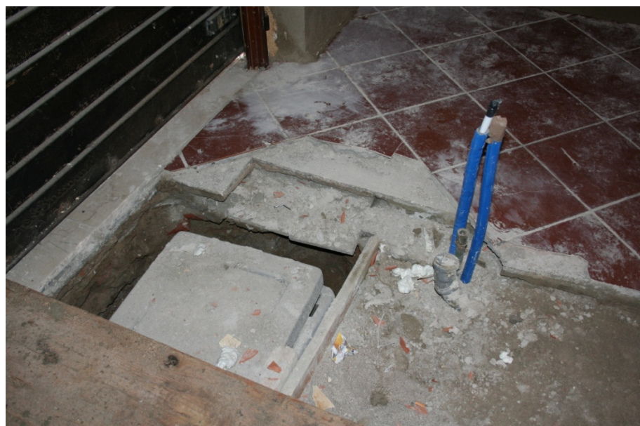
Dettaglio di un pavimento posato su massetto semplice e terreno.
