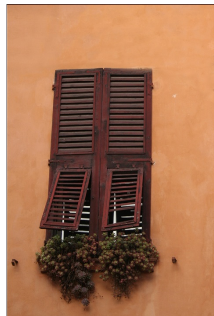
Una persiana a doppia anta con gelosia inclinabile.
