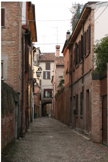
Via delle Volte, asse di ristrutturazione all'interno delle corti fronteggianti la riva del Po.
