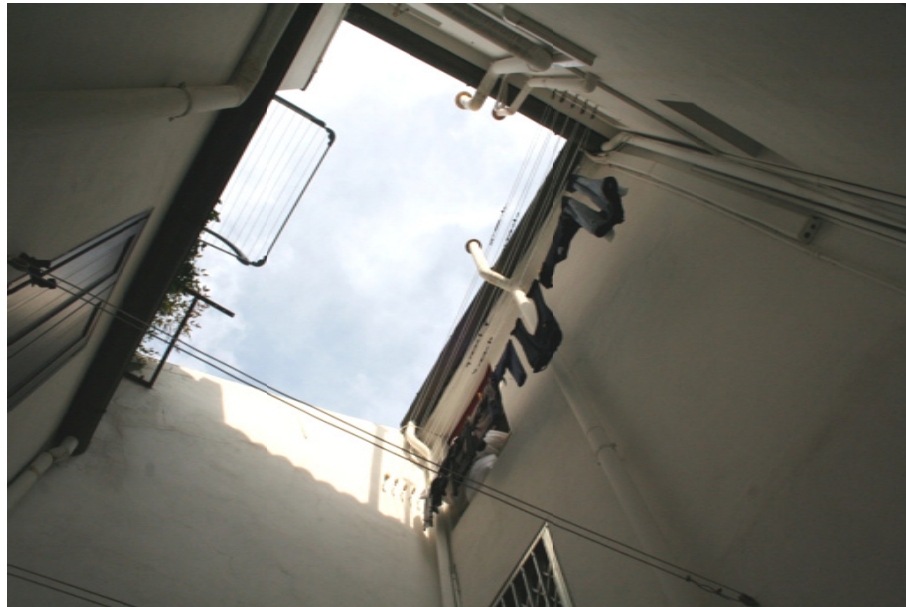
Vista di un pozzo luce tipico delle case in linea di rifusione da case a schiera.
