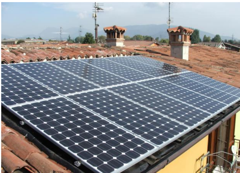
Inserimento di pannelli fotovoltaici e pannelli solari al di sopra di una copertura in coppi (di tipo tradizionale a sinistra ed industriale a destra).
