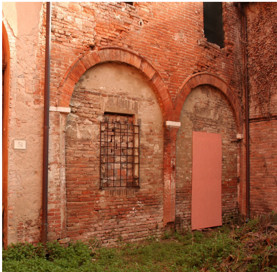
Loggia interna tamponata, con adiacente accesso all'androne.
