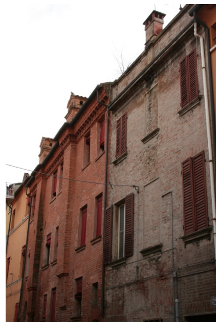
Esempio di casa a schiera con camini a sbalzo esterno (sul fondo) e incassati nel muro (in primo piano).
