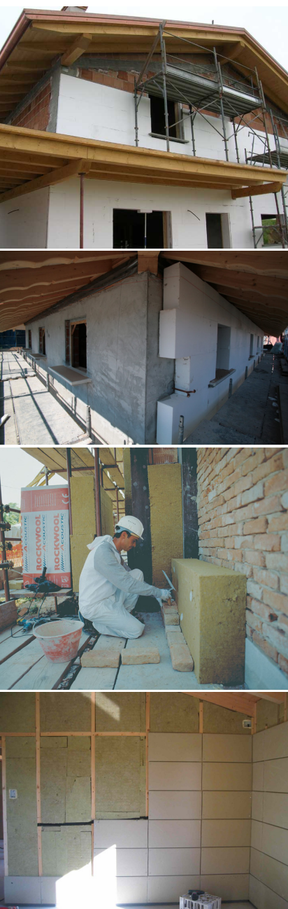
Installazioni di pannelli isolanti termici, rigidi o semi-rigidi, su pareti esterne (in alto) ed interne (in basso).
