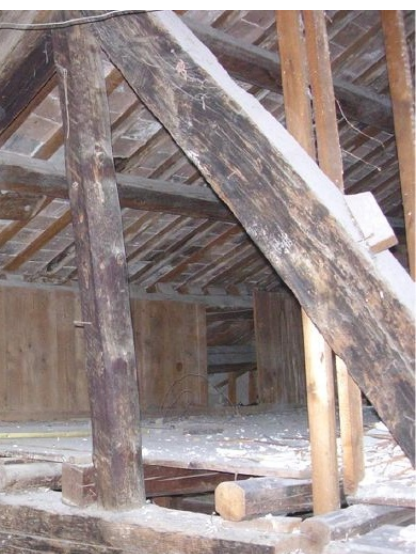
Sottotetto in fase di cantiere, con capriate la cui catena funge da trave portante del solaio verso il vano sottostante.
