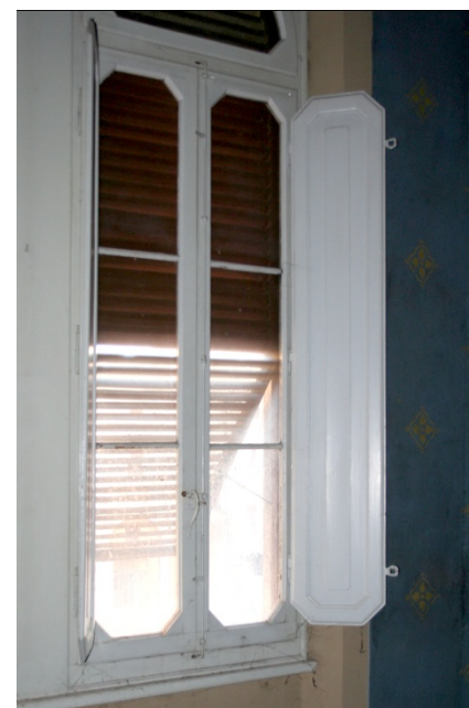
Scuro sagomato secondo le specchiature del serramento.
