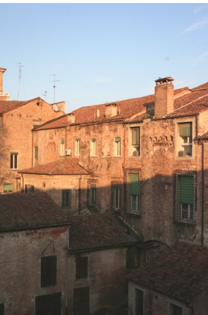
Manti di copertura in coppi.
