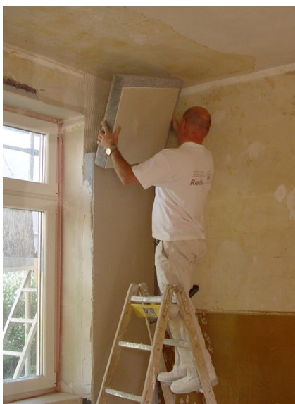
Esempi di inserimento di isolamenti interni o esterni su murature perimetrali..
