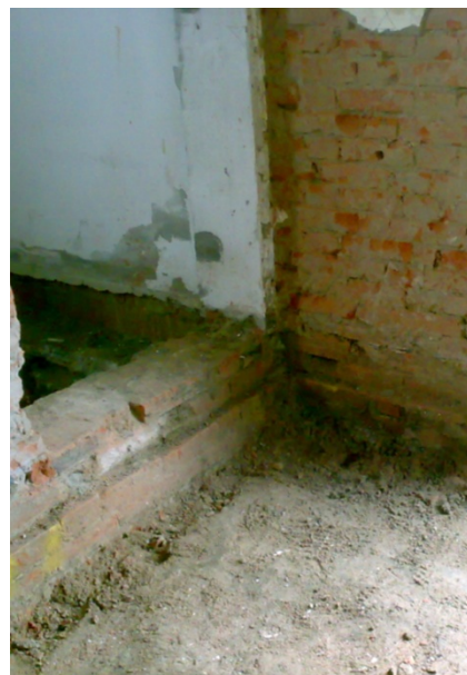
Dettaglio del rifacimento del piano di un solaio a terra, con battuto di terra, sopra vespaio in ghiaia.
