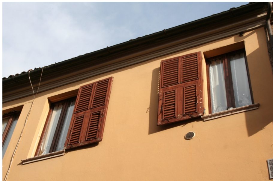
Esempio, non molto diffuso, di persiana ad anta unica, con disegno a simulare una conformazione a doppia anta.
