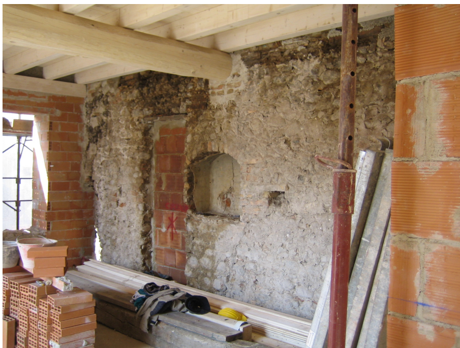
Il cantiere di restauro di un edificio pre-industriale induce necessariamente trasformazioni e alterazioni che devono essere individuate a seguito di un processo conoscitivo attento, in grado di valutare la loro compatibilità.
