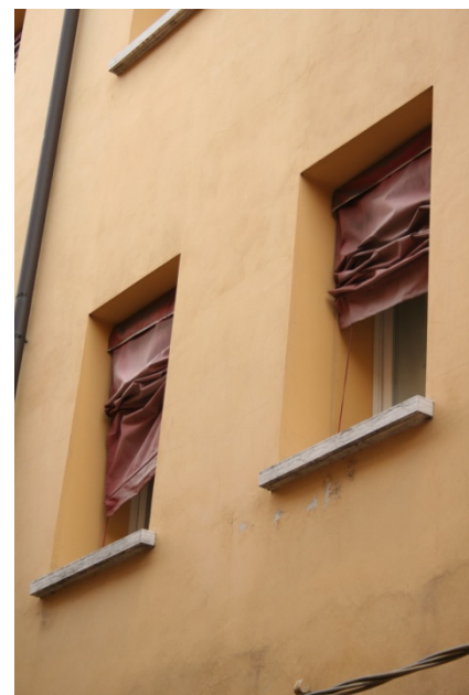
Dettaglio dello spessore indotto da un pannello isolante
