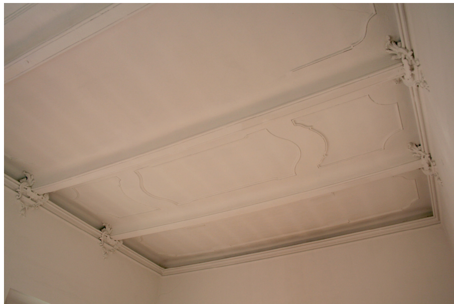
Esempio di solaio ligneo foderato con stuoie di canna e decorazioni a stucco.
