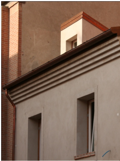
Sfruttamento di sottotetto con la formazione di abbaino.
