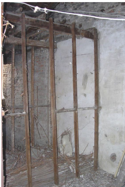
Esempio di parete divisoria in tralicci di legno e stuoie di arella, posta entro una singola unità immobiliare.
