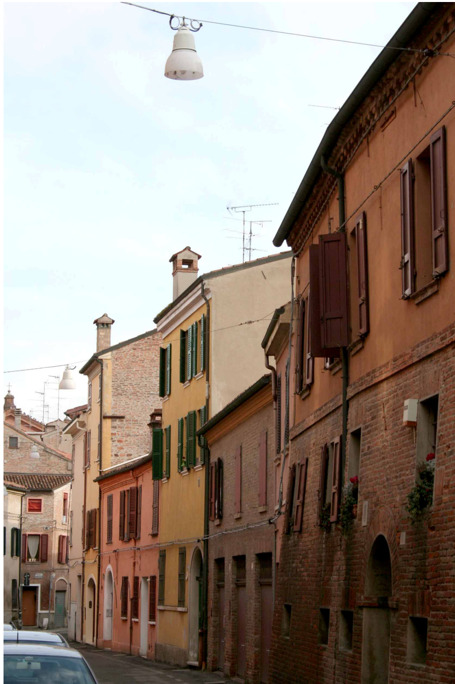
Sequenza di edifici molto discontinui nelle quote, ove si determinano situazioni di dispersione termica sulle pareti perimetrali.
