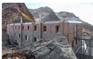
Illustrazione 63 | I terminali impiantistici sono concentrati nel lato a nord (meno esposto e visibile) dell'edificio.
