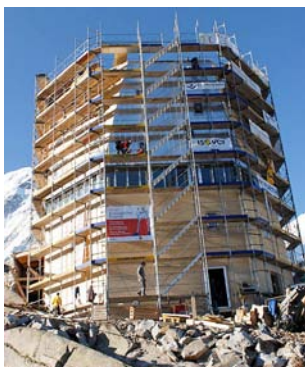
Illustrazione 2 | Durante le fasi di realizzazione sono stati attentamente organizzati turni di permanenza in quota di gruppi di operai specializzati. Nella foto: fase di costruzione e di finitura del rifugio Monte Rosa Hütte, 2795 m, Zermatt, Svizzera.
