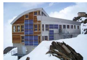
Illustrazione 66 | Dettaglio della facciata principale del rifugio. Sono visibili i pannelli fotovoltaici integrati nella chiusura verticale.
