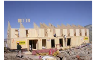
Illustrazione 54 | Fase di costruzione del rifugio. La struttura prefabbricata in legno è stata trasportata in loco e fissata in opera con l'ausilio dell'elicottero.
