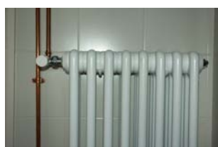
Illustrazione 37 | Termosifone alimentato dall'acqua generata dalla cucina economica. Nella foto: installazione nei bagni del rifugio Tissi, Col Rean-Civetta (BL), 2250 m, CAI Belluno.
