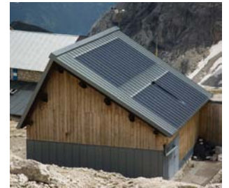
Illustrazione 8 | Impianto fotovoltaico realizzato su una falda di copertura con il contributo del progetto di finanziamento europeo CAI Energia 2000.
