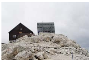
Illustrazione 11 | Rifugio capanna Fassa, 3151 m Piz Boé, gruppo del Sella (TN), privato. Il rifugio è costruito in vetta ed è visibile a distanza anche l'antenna situata sulla destra del rifugio.
