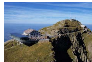
Illustrazione 62 | Vista dell'intero complesso e del sistema di risalita ad esso collegato.
