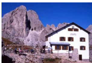
Illustrazione 3 | Nella foto: rifugio Roda di Vaél, prima della suo intervento di riqualificazione. È ben visibile la finitura esterna intonacata.
