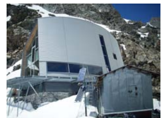
Illustrazione 5 | La nuova struttura si differenzia dall'edificio originale e non conserva le sue caratteristiche formali e volumetriche. La nuova costruzione è stata realizzata con sistemi a secco in legno e metallo e ultimata nel 2010.
