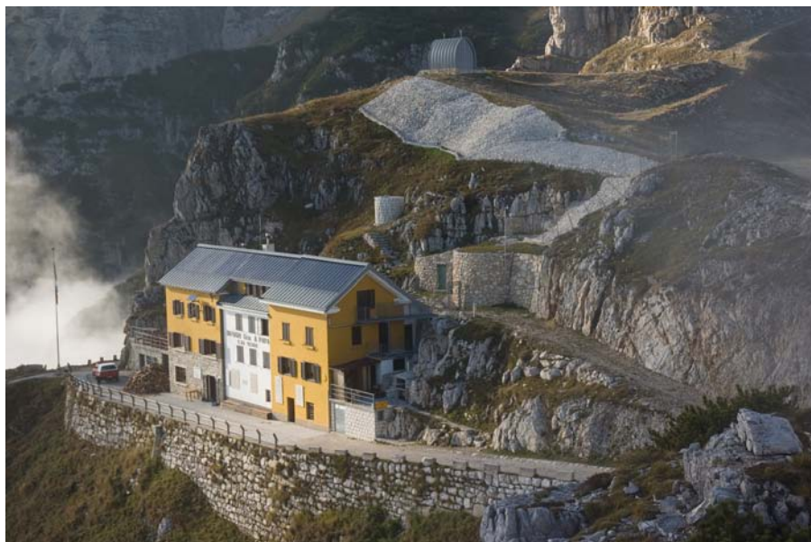
Illustrazione 7 | Sul retro del rifugio è stata realizzata un'area impermeabilizzata (visibile perché più chiara) finalizzata alla captazione idrica. L'acqua piovana è infatti l'unico sistema di acquisizione della risorsa idrica. Rifugio Papa, Monte Pasubio (VI), 1929 m, CAI Schio (VI).
