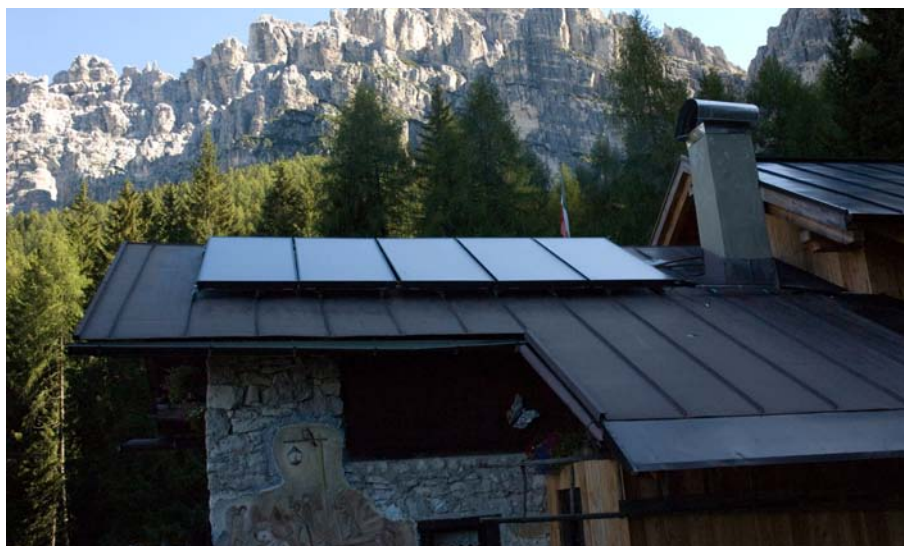
Illustrazione 9 | Rifugio Casera Bosconero, Val Zoldana (BL), 1457 m, CAI Forno di Zoldo. La posizione a ridosso del monte e l'alta alberatura circostante non consentono al rifugio di sfruttare a pieno l'esposizione solare fino a tarda mattinata (sono visibili anche sistemi di captazione solare in ombra).
