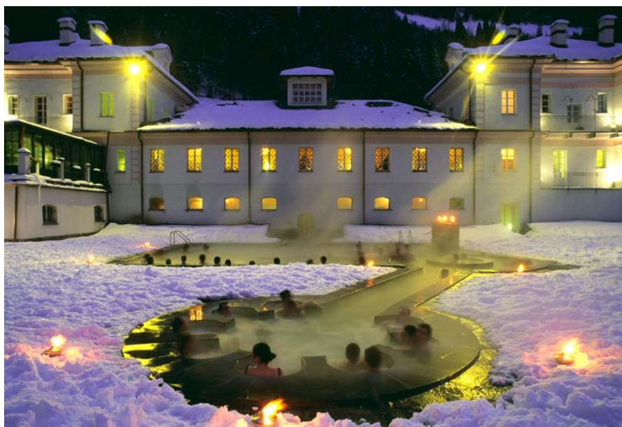
Illustrazione 12 | L'edificio è stato realizzato in contesto isolato per sfruttare la presenza di sorgenti termali naturali a ridosso della montagna. Nel caso specifico la funzione ricettiva è demandata a strutture idonee presenti (e insediatesi nel tempo) nel territorio circostante. L'edificio si è specializzato nei servizi di cura e trattamenti per i non "residenti". Nella foto: stazione termale a Allée des Thermes Pré-Saint-Didier (AO).
