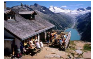
Illustrazione 44 | Considerata l'esigenza di ingrandire la parte esterna e dotare la struttura di più spazio per la ricettività, il vecchio rifugio è stato demolito nel 2005. In sostituzione è stata realizzata una nuova struttura in pannelli di legno multistrato. Nella foto: il vecchio rifugio Olperer, Austria.
