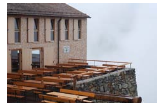
Illustrazione 45 | Nel 2005 dopo la demolizione del vecchio rifugio, si è proceduto ad una rapida ricostruzione del nuovo rifugio. Il montaggio delle parti strutturali, comprensive delle chiusure, è avvenuto in soli due giorni con l'ausilio di un elicottero per il trasporto in loco dei setti prefabbricati in multistrato, assemblati poi in cantiere. Nella foto: il nuovo rifugio Olperer, Austria.
