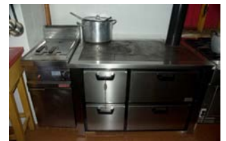
Illustrazione 34 | Il calore prodotto per la preparazione dei cibi può essere sfruttato per riscaldare alcuni locali tramite appositi impianti. Nella foto: cucina economica al rifugio Tissi, Col Rean-Civetta (BL), 2250 m, CAI Belluno.
