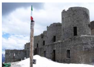
Illustrazione 2 | Nella foto: resti di un forte italiano sul monte Chaberton (TO), al confine tra Francia e Italia a 3130 m. È stato distrutto nel 1943.
