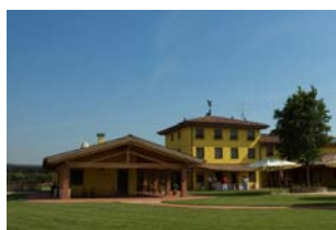
Illustrazione 22 | Complesso agriturismo. Generalmente è localizzato in contesto rurale, ma facilmente raggiungibile con mezzi ordinari.
