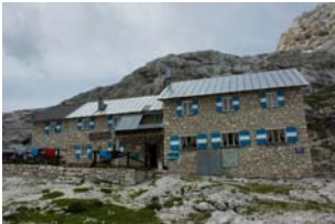
Illustrazione 23 | La massa derivante dall'utilizzo di murature in pietra aumenta l'inerzia termica della struttura, ritardando i tempi di riscaldamento. Nella foto: il rifugio Volpi al Mulaz (BL), 2560 m, CAI Venezia.
