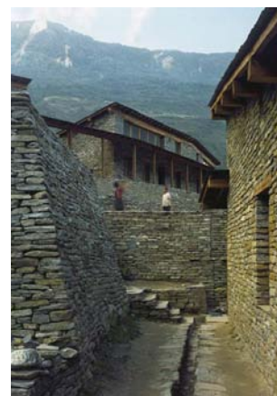
Illustrazione 10 | La realizzazione dell'opera è stata finalizzata attraverso la scelta di impiegare materiali reperibili nelle vallate circostanti e grazie all'attento coordinamento delle maestranze locali.
