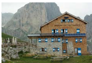
Illustrazione 4 | Nella foto: rifugio Roda di Vaél, gruppo del Catinaccio (TN), 2280 m, SAT. Nella riqualificazione è stato realizzato un cappotto esterno coperto da una finitura in scandole di legno.
