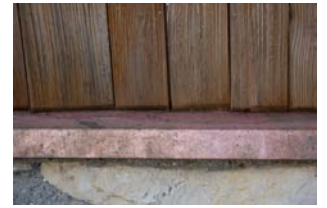
Illustrazione 19 | Dettaglio dell'attacco del rivestimento in scandole di legno allo zoccolo in pietra sottostante. Sulla soprastante muratura in pietra è stata realizzato l'isolamento a cappotto, poi ricoperto in scandole (finitura esterna). Nella foto: rifugio Roda di Vaél, gruppo del Catinaccio (TN), 2280 m, SAT.
