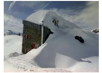
Illustrazione 3 | Rifugio alpino innevato durante la stagione invernale. Tali condizioni possono perdurare per mesi e dare luogo a infiltrazioni e danneggiamenti (anche strutturali).
