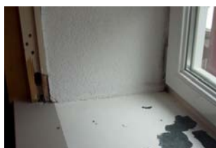
Illustrazione 14 | Le murature dei rifugi alpini in genere non sono coibentate. In questo caso è visibile però, a destra, un infisso dotato di vetrocamera. Nella foto: installazione presso il rifugio Berti al Popera (BL), 1950 m, CAI Padova.
