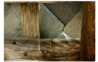
Illustrazione 13 | Vista interna di una chiusura superiore realizzata con pietre sagomate, sovrapposte nella posa e poggiate direttamente sopra le travi e la listellatura in legno (tetto inclinato). Non sono utilizzati in questo caso sistemi di impermeabilizzazione. Nella foto: rifugio Arlaud, Montagne seu Salbertrand (TO), 1770 m.
