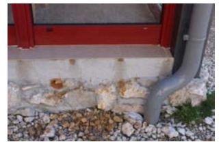
Illustrazione 16 | Solaio a terra aerato, realizzato durante le fasi di ristrutturazione e di ampliamento del rifugio e la costruzione di un locale-serra esposto a sud. È visibile a sinistra il tubo che permette la ventilazione.
