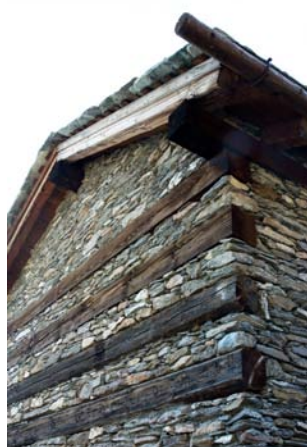
Illustrazione 7 | Particolare delle chiusure verticali esterne realizzate in legno e pietre locali.
