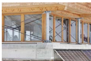
Illustrazione 49 | Dettaglio della grande vetrata della sala comune al primo piano. È visibile l'utilizzo del legno nella parte sopraelevata e del calcestruzzo armato nella chiusura del solaio interpiano.
