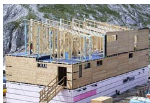
Illustrazione 47 | È frequente l'utilizzo di sistemi a secco, in particolar modo in legno, negli interventi di riqualificazione o di ricostruzione dei rifugi alpini. Nella foto: Rifugio Schliethaus am Hochschwab, Austria, durante la costruzione del 2004 (tratta da www.robertsalzer.at ).
