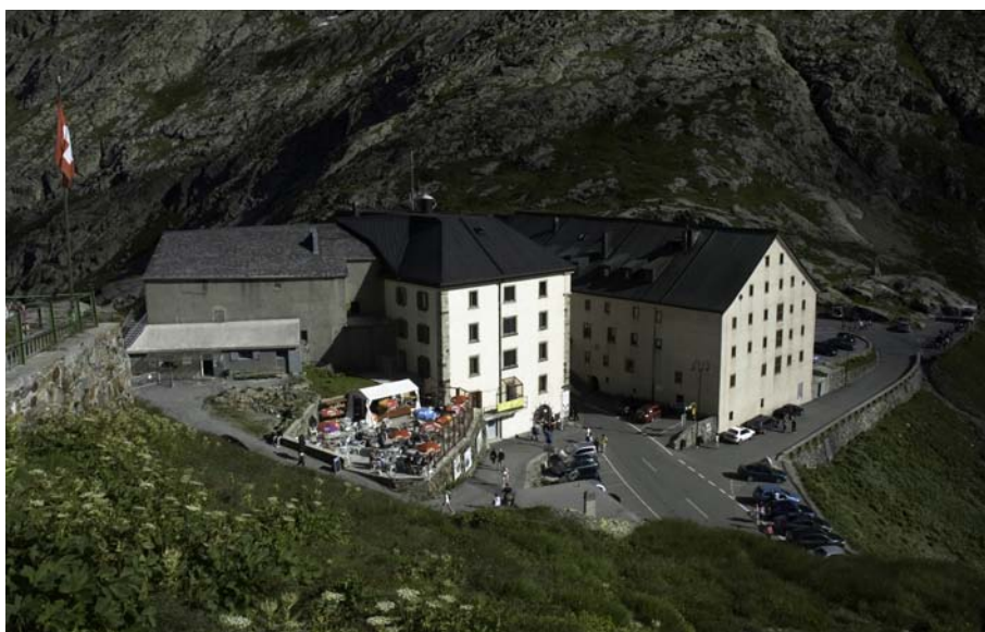
Illustrazione 15 | Vista d'insieme della struttura dell'Ospizio del Gran San Bernardo. È situata sul valico omonimo che divide la Svizzera dall'Italia. Con rinnovamenti e nuove aggiunte, il Passo è presidiato da oltre dieci secoli.
