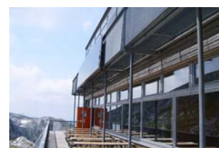
Illustrazione 58 | Dettaglio della finestra panoramica del rifugio. Tale elemento è utilizzato anche al fine di favorire il guadagno solare diretto.
