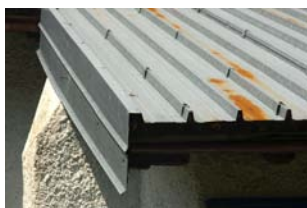
Illustrazione 15 | Copertura in lamiera metallica posata su tavolato in legno. In seguito ad una ristrutturazione, è stata realizzata una coibentazione al di sotto del manto di chiusura superiore.
