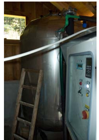
Illustrazione 30 | Digestore anaerobico sperimentale per la produzione di biogas dagli scarti organici (feci solide e umido). Il funzionamento prevede il mantenimento di condizioni ottimali di carico e di temperatura e richiede la presenza di personale tecnico specializzato. Nella foto: apparecchiatura in fase attuale di sperimentazione (per conto dell'Università degli Studi di Padova) presso il rifugio Casera Bosconero, Val Zoldana (BL), 1457 m, CAI Forno di Zoldo.
