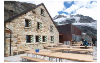
Illustrazione 64 | Con l'edificio esistente è visibile la nuova costruzione, ad ampliamento delle funzioni comuni, in particolare della sala di ristoro.
