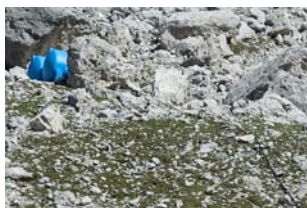
Illustrazione 5 | Vasche dedicate all'accumulo di acqua posizionate a monte del rifugio e predisposte come riserva nel caso di temporanea carenza di fornitura.
