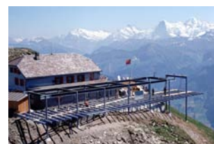
Illustrazione 61 | Dettaglio della struttura in acciaio, in fase di costruzione.
