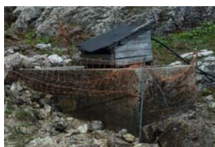
Illustrazione 25 | Pozzetto fisso per il prelievo dell'acqua proveniente da una sorgente potabile.
