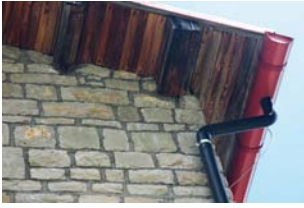
Illustrazione 18 | Muratura, realizzata con pietre locali. Il suo spessore può variare a seconda del numero dei piani e delle tecniche costruttive impiegate (possono anche variare gli spessori di muratura nello stesso edificio).
