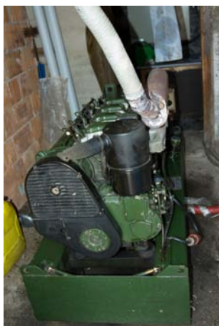
Illustrazione 6 | La necessità di disporre di impianti sempre funzionanti spinge i gestori ad utilizzare sistemi più semplici e considerati più affidabili. Nella foto: un generatore alimentato a diesel, in funzione presso il rifugio Volpi al Mulaz (BL), 2560 m, CAI Venezia.
