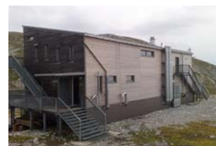
Illustrazione 57 | Vista del lato nord del rifugio: la parete ha pochissime aperture ed inoltre ospita i terminali e gli scarichi impiantistici.
