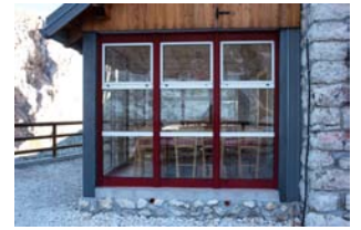
Illustrazione 13 | La serra solare consente lo sfruttamento passivo del calore solare oltre che permettere la visione del panorama.
