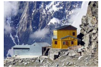
Illustrazione 4 | Nella foto: Vecchio rifugio Gonella, Monte Bianco (TO), 3071 m, CAI Torino, demolito.
