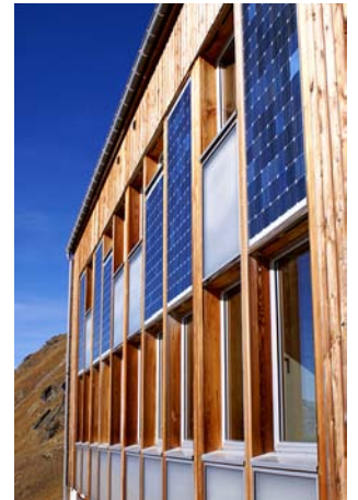
Illustrazione 50 | Particolare del fotovoltaico integrato nei tamponamenti opachi verticali della facciata esposta a sud.
