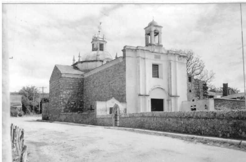
Ilustración 72 Arriba Fachada de la Iglesia antes de la Restauración (Archivo Grenón) Abajo después de la Restauración (Archivo Plattner SJ-Bild/Plattner)
