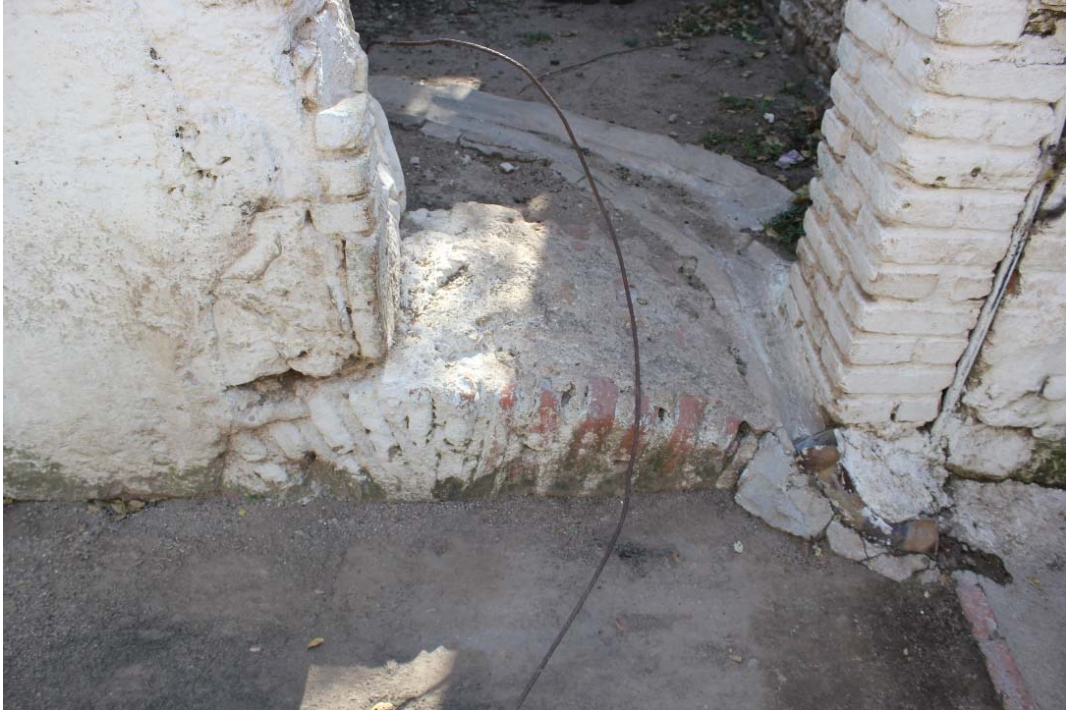
Ilustración 87 Arco en la Puerta. Posiblemente la bóveda de la acequia para llevar el agua hacia la huerta (Foto Arq Melina Malandrino)
