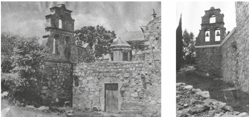
Ilustración 79 Espadaña y Sacristía. Izquierda antes de la restauración, derecha después de la restauración (Archivo Grenón)
