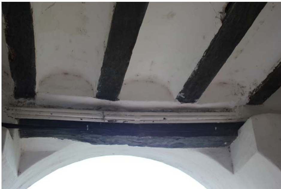
Ilustración 53 Bóvedas de revoltón y arranque de los arcos y bóvedas de aristas truncadas. ph. Pedro Cufre
