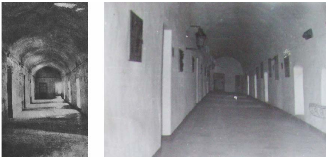
Ilustración 77 Corredor cubierto de bóveda del área Norte. Izquierda antes de la Restauración. Derecha después de la restauración (Archivo Grenón)
