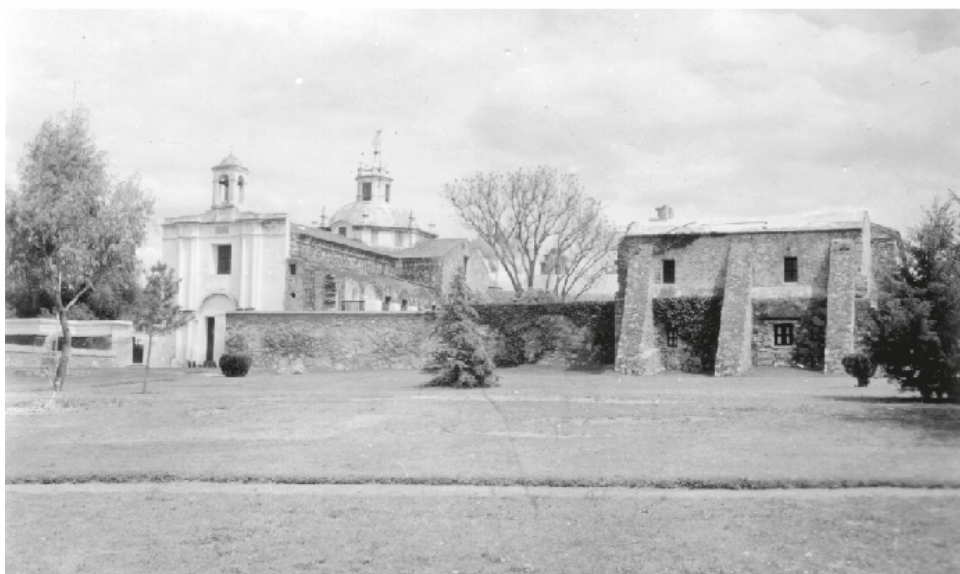
Ilustración 73 Vista del Conjunto desde el sector este, arriba antes de la Restauración (Archivo Grenón), debajo después de la Restauración (Archivo Plattner SJ-Bild/Plattner)
