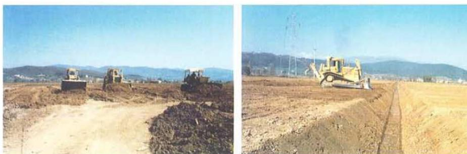
3.4 – Immagini del lavoro di livellamento dei campi e di scavo delle trincee di drenaggio (da Mosco et al. 1994).
