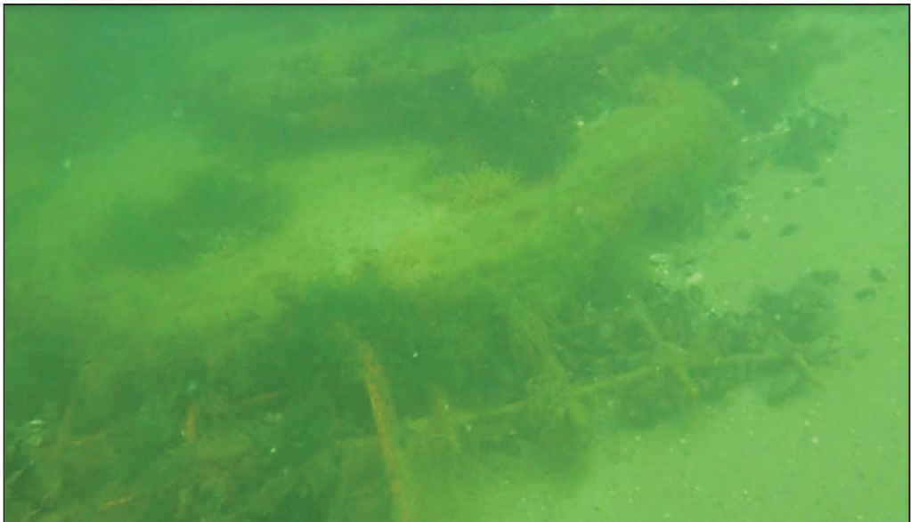
Fig. 9.15 - Foto subacquea del cedimento strutturale di un modulo del reef. Le piastre sono appoggiate sul fondo ed impilate l'una sull'altra. Giugno 2012.
