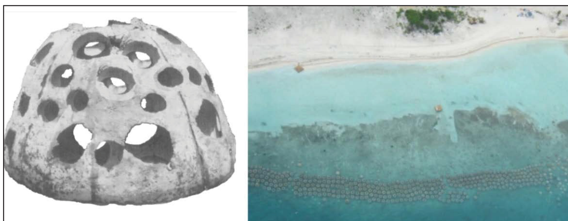
Fig. 5.2 – Reef Ball TM e foto aerea di una barriera composta da 5 linee di Reef Ball in Antigua (Caraibi) (Harris, 2003).
