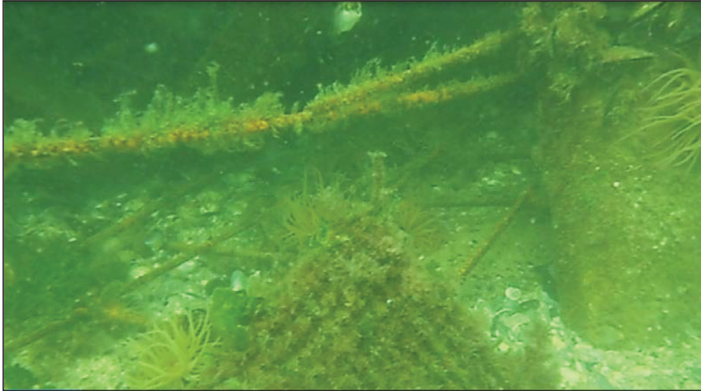
Fig. 9.14 - Foto subacquea di un modulo del reef collassato. In evidenza la rottura della rete elettrosaldata. Giugno 2012.
