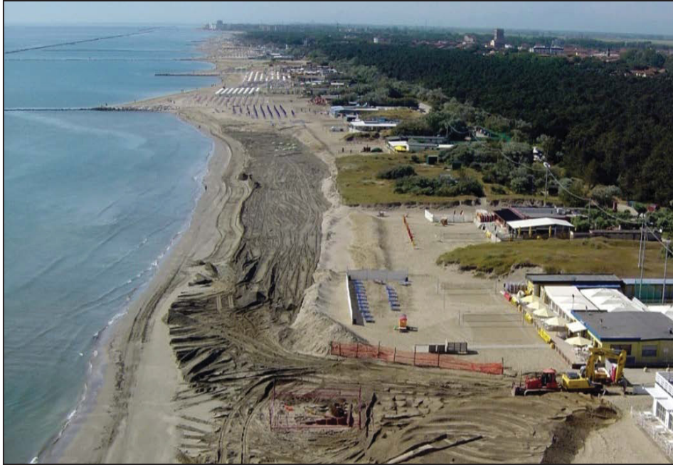
Fig. 6.25 – Foto della fase di realizzazione del ripascimento della spiaggia emersa.
