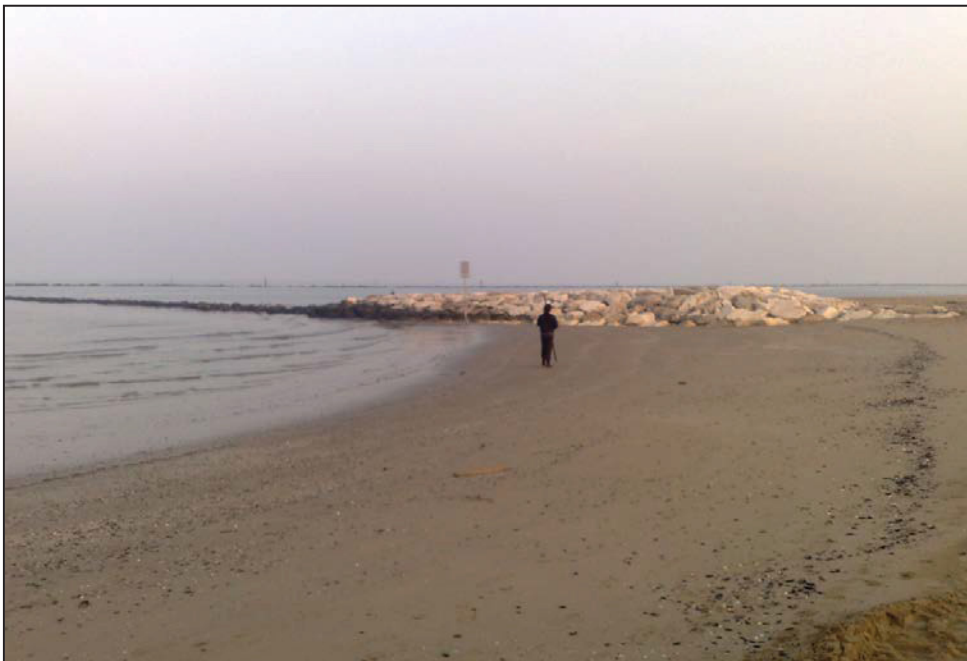
Fig. 6.12 – Foto dell'undicesimo pennello del sistema di barriere foranee e pennelli a difesa dell'abitato di Punta Marina, zona meridionale del tratto indagato.
