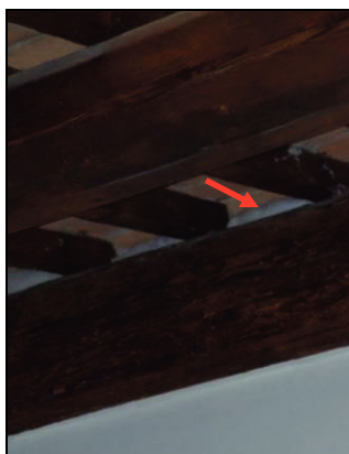
Figura 28: particolare dell'inserimento del materiale fonoassorbente nel ponte acustico (intervento provvisorio)
