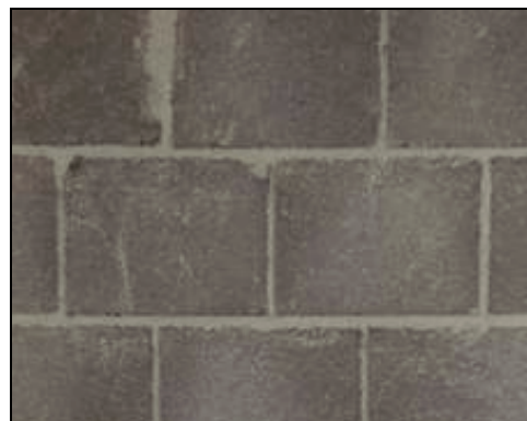
Figura 12: esempio di posa corretta della malta anche nei giunti verticali
