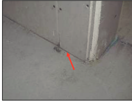
Figura 67: esempio di fascia perimetrale rifilata prima della posa del pavimento
