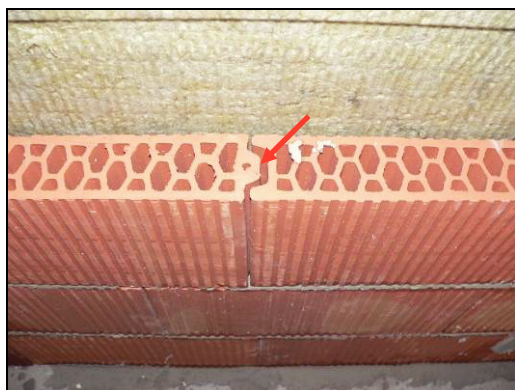
Figura 23: esempio di unione non ottimale dei blocchi ad incastro
