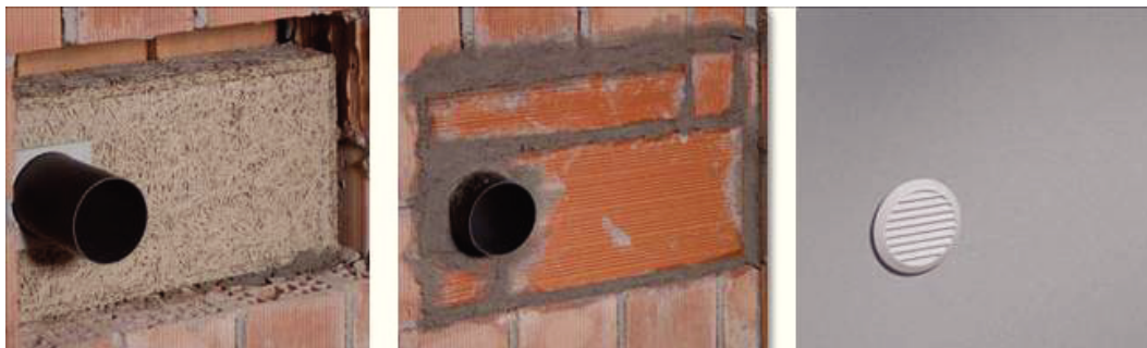
Figura 55: esempio di corretta posa in opera di un silenziatore per foro di ventilazione
