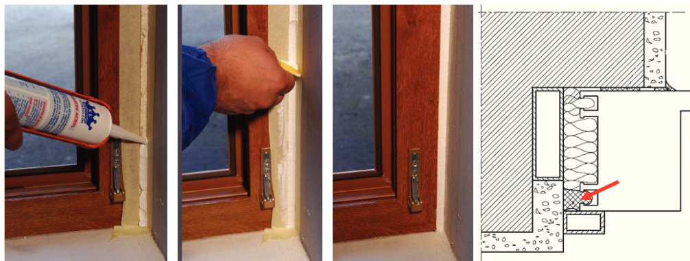
Figura 50: esempio di corretta applicazione del sigillante sulla parte interna del giunto [49]
