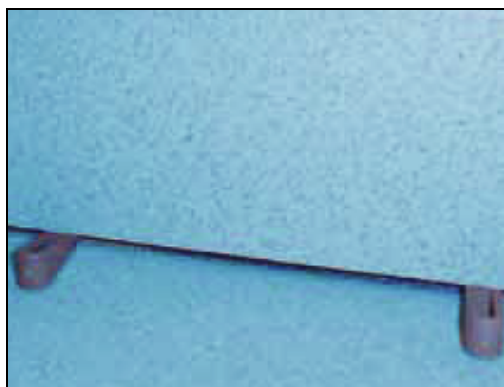
Figura 86: esempio di posa corretta del rivestimento a parete mediante inserzione di distanziatori [51]
