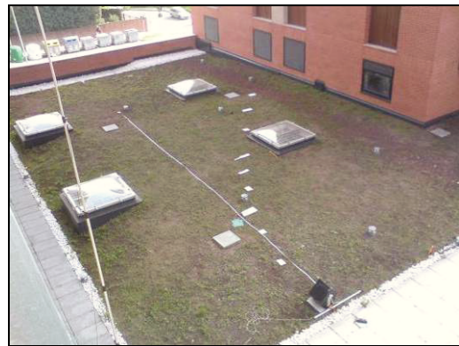
Figura 44: vista delle posizioni dell'altoparlante nelle misure in opera, per la facciata con balcone
