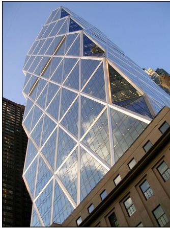
Img. 4.11 & 4.12 - La Hearst Tower di Foster a New York, è uno dei più conosciuti esempi a diagrid. Grazie a questo tipo di struttura, formata da elementi diagonali che si uniscono formando dei triangoli rigidi, è possibile realizzare delle importanti economie di materiali.
