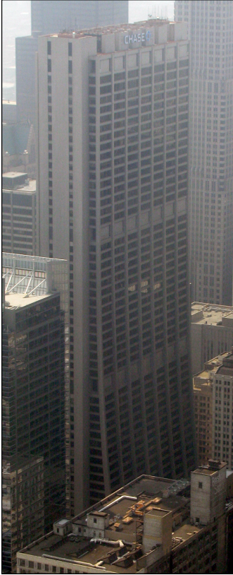
Img. 8.16 - Il Chase Building di Chicago, ha due service core posti sui lati corti dell'edificio. Tale configurazione, oltre a risultare pratica ai fini dell'organizzazione dell'edificio in più tenant, assicura anche una maggiore efficacia delle vie di fuga, rendendo il sistema di evacuazione più sicuro.
