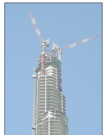
Img. 8.02 - La sommità del Burj Dubai, ancora in fase di costruzione nel marzo 2008, pone in evidenza la presenza del core strutturale.
