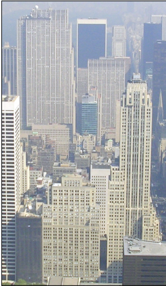
Img. 8.03 - Il Rockefeller Center, la cui forma caratterizzata dai numerosi setback è stata più volte descritta come conseguenza della zoning law, è in realtà frutto della deliberata intenzione dei progettisti. Nella foto in alto, in primo piano, è invece possibile notare la forma del 500 Fifth Avenue, con la caratteristica torre e i setback, in questo caso veramente dettati dall'esigenza di conformarsi alla Zoning Law
