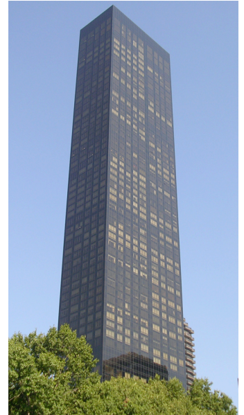
Img. 3.08 - La Trump Condo tower di New York, completata nel 2001 è un esempio abbastanza raro di edificio dalla colorazione scura costruito dopo la crisi energetica. Sotto molti aspetti architettonici e tecnologici, il grattacielo è molto simile alle torri della terza generazione.
