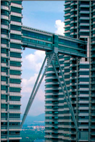
Img. 11.05 - Lo skybridge delle Petronas Towers di Kuala Lumpur mette in comunicazione i due edifici fornendo una via alternativa per la fuga in caso di evacuazione. Grazie a questa soluzione, sulla cui applicabilità sono in corso numerosi studi, è possibile ridurre il numero delle scale di fuga, creando di conseguenza notevoli risparmi nell'embodied energy del grattacielo.
