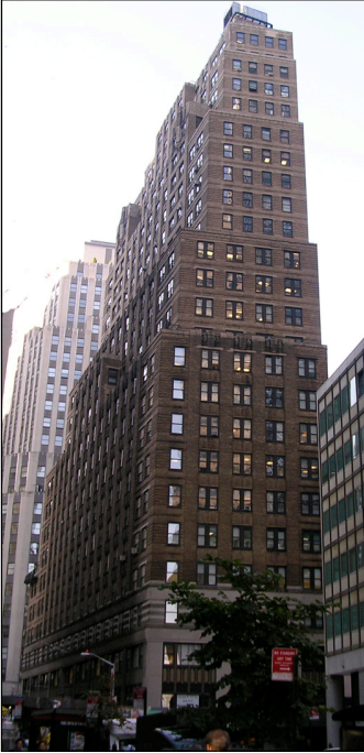
Img. 1.01 - I grattacieli di New York che occupano interamente la sagoma lasciata disponibile dalla Zoning Law sono un ottimo esempio di intervento speculativo: la volumetria concessa dalla sagoma limite imposta dalla normativa urbanistica dell'epoca viene sfruttata appieno per il conseguimento del massimo profitto.
