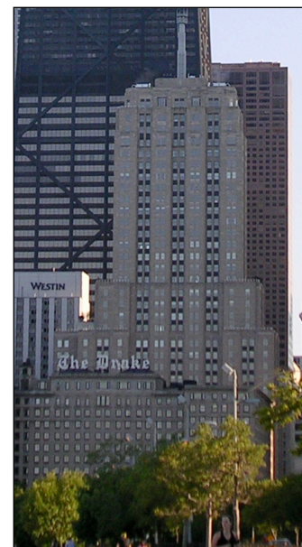
Img. 7.14 - Il Palmolive Building di Chicago (1929) è uno dei numerosi esempi di grattacieli costruiti secondo la "moda del setback" in una città in cui non esisteva un regolamento che richiedesse l'utilizzo degli arretramenti propri dell'architettura newyorkese.
