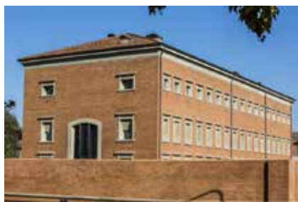
EX CARCERE COMPLETATO Veduta esterna del fronte sud-ovest. Outside view of the south-west front. http://www.ferrara24ore.it/news/ferrara/0016419-meis-inaugurazione-alla-presenza-del-presidente-della-repubblica
