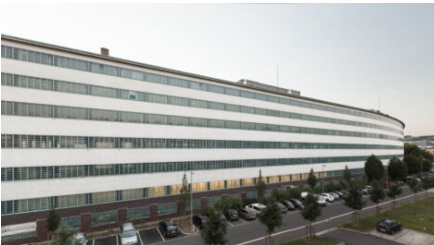
Il corpo principale della Tabakfabrik
