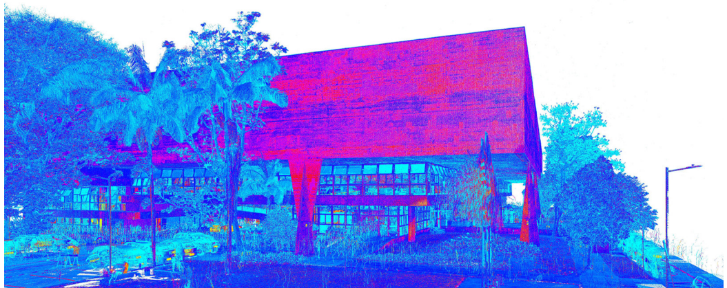
FAU USP, Faculdade de Arquitetura e Urbanismo da Universidade de São Paulo, Brazil. View of an integrated three-dimensional survey from a terrestrial laser scanner. Main entrance. Credits: DIAPReM/TekneHub Laboratory, UNIFE.
