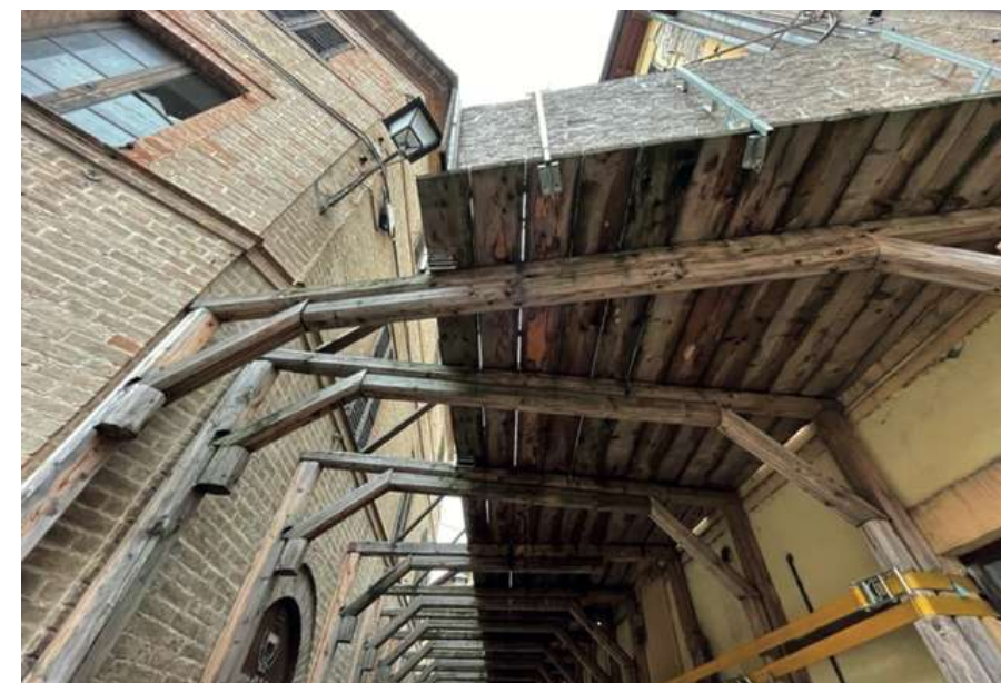
02. Tolentino (Mc) Opere provvisorie e interventi di recupero negli spazi urbani del centro storico | Provisional works and recovery interventions in the urban spaces of the historic centre
