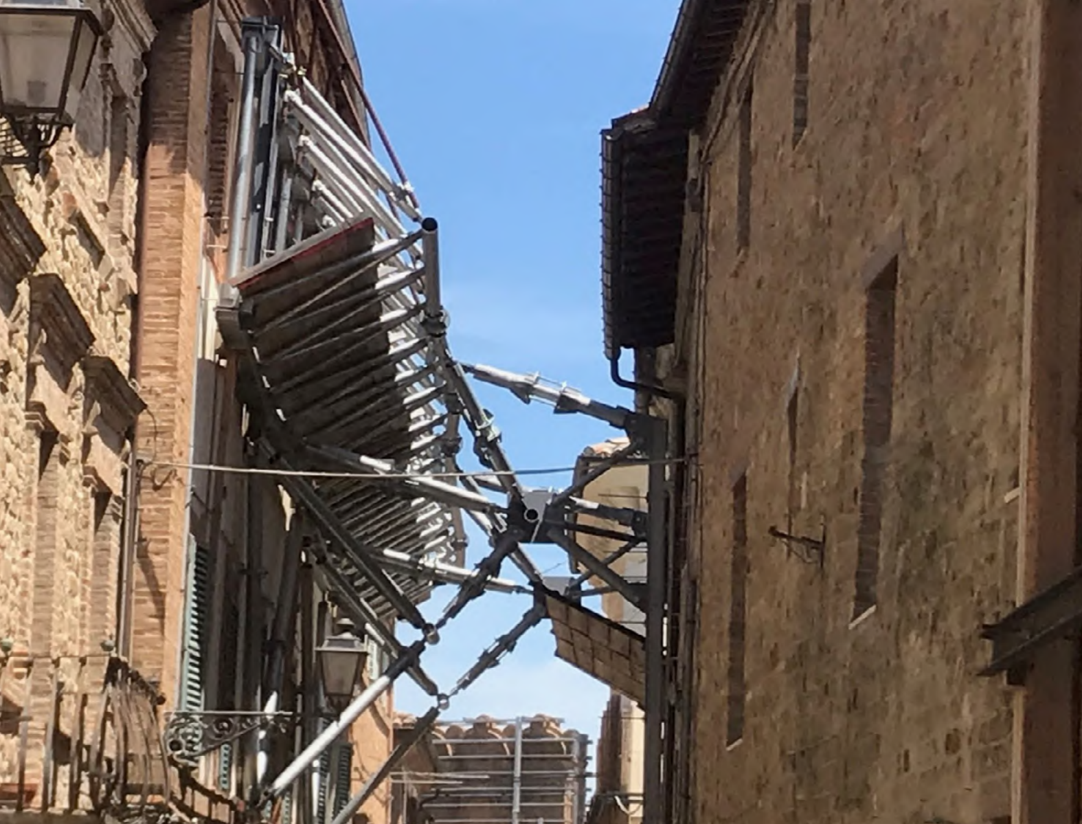
01. San Ginesio (Mc) Opere provvisorie per la messa in sicurezza della "direttrice principale" di via Capocastello | Provisional works for the safety of the "main route" of via Capocastello
