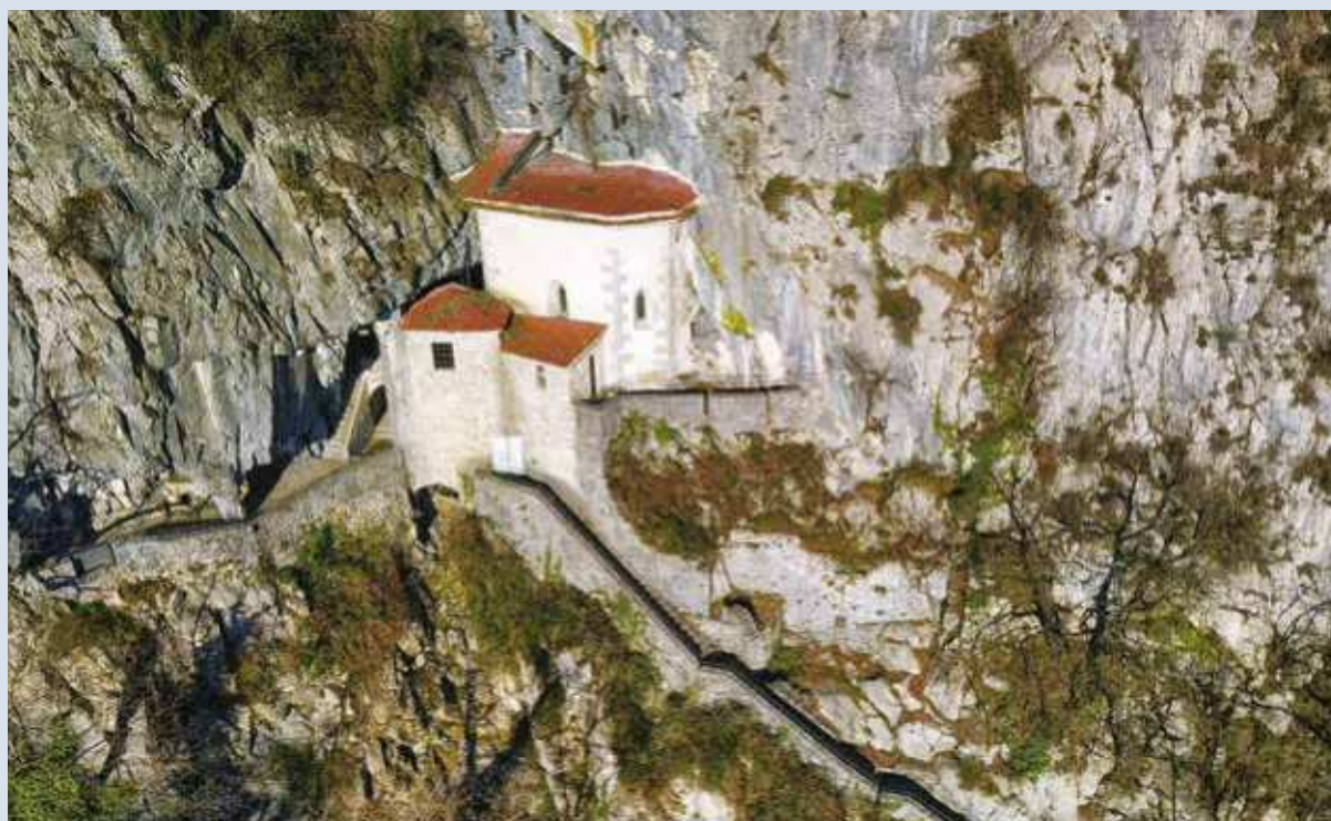
123 > La chiesa e le altre strutture all'ingresso della Grotta di San Giovanni d'Antro (Pulfero).
