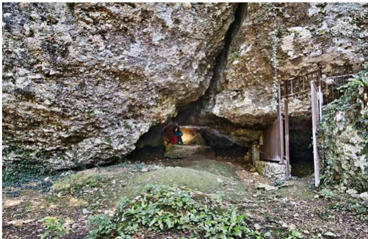
21 > I conglomerati fluviali nei quali si apre il Riparo di Biarzo (San Pietro al Natisone): è evidente la frattura che ha portato al crollo di parte della volta del riparo.
