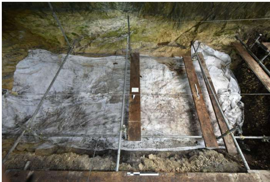
Fig. 1 – Il Landro durante l'apertura del cantiere.
