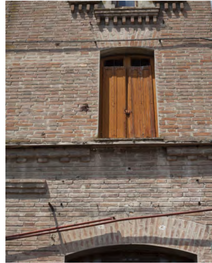
east facade- via martiri della liberta
