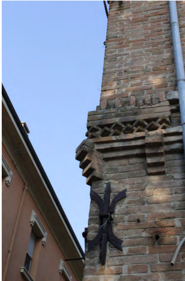
east facade- via martiri della liberta
