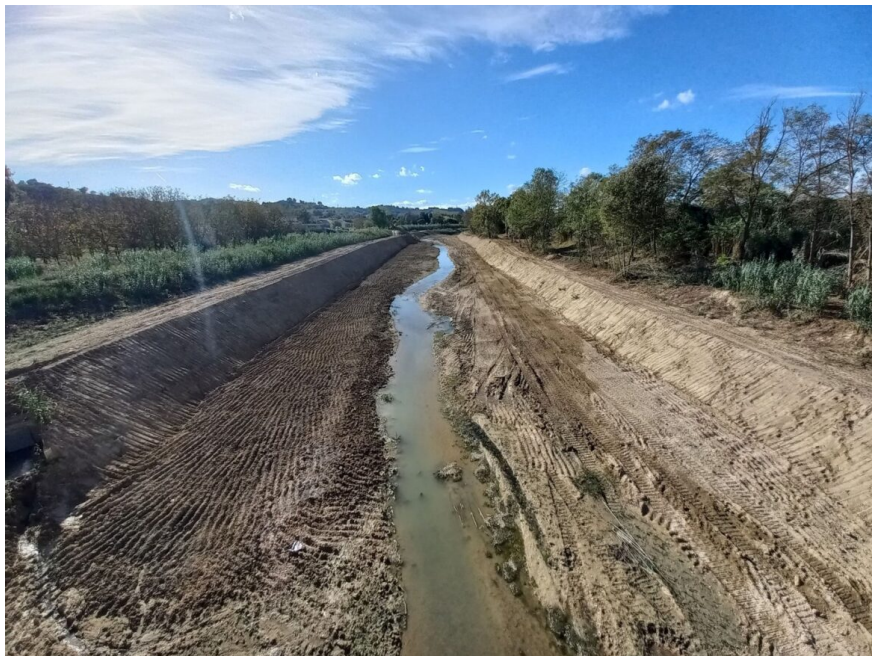
Fiume Misa, Ancona. Intervenire sugli alvei dei fiumi in modo aggressivo, regolarizzando il loro corso e velocizzando il flusso delle acque, non contribuisce alla sicurezza idraulica e comporta rilevanti perdite di biodiversità (©Alessandra Marin)
