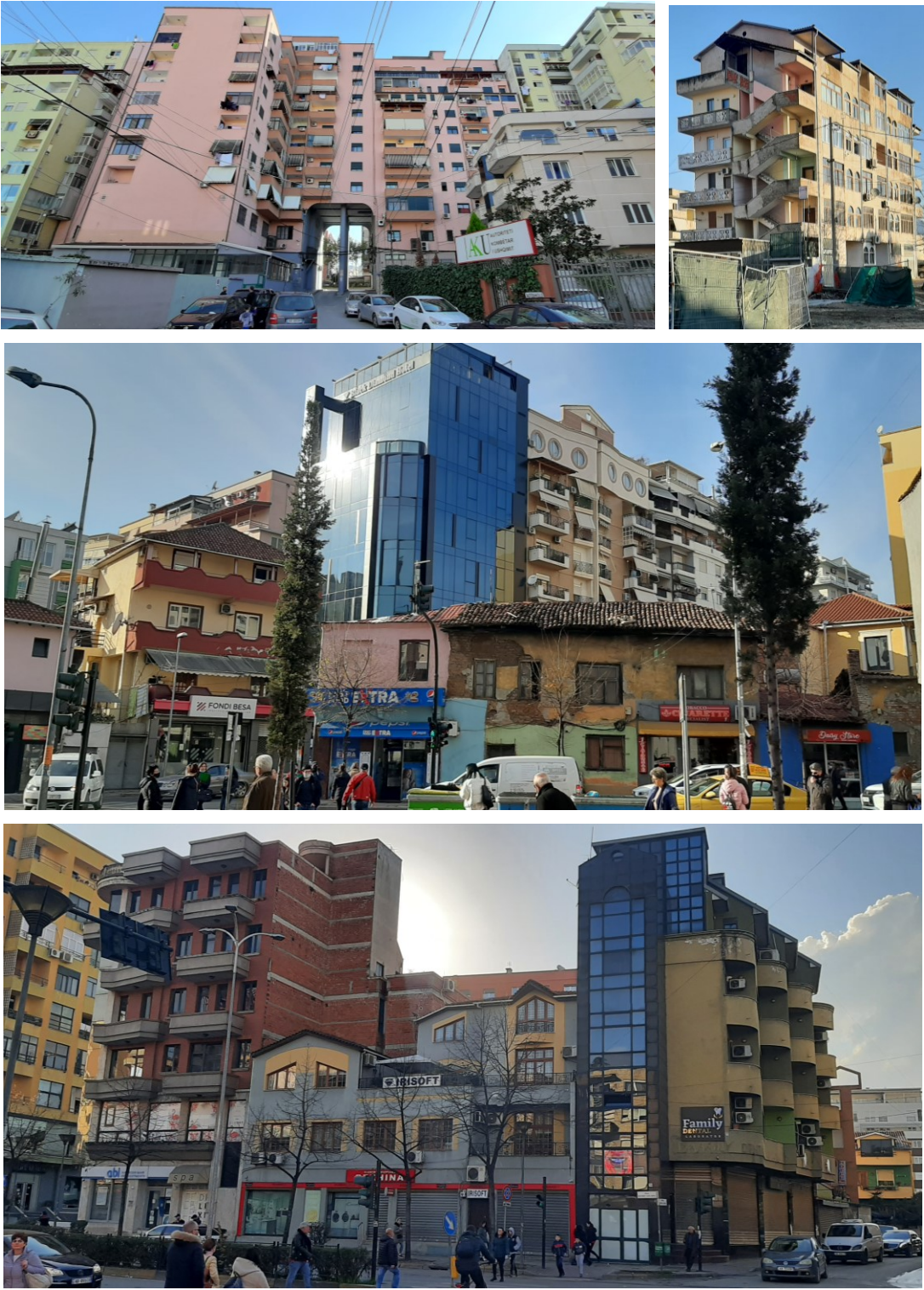
Figure 60. Ndertesa banimi, tipologji "mix", te pas viteve '90 ne Tirane.
