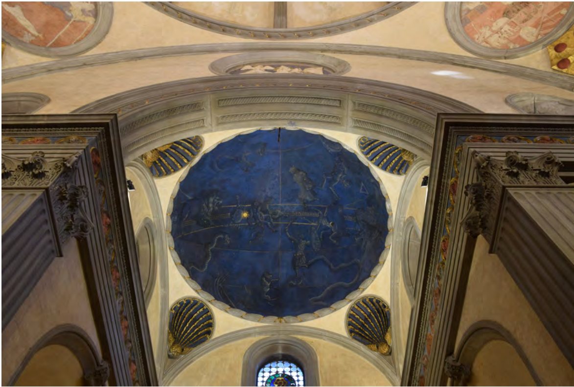
3. Cupola della scarsella della Sacristia Vecchia di San Lorenzo (Firenze).
