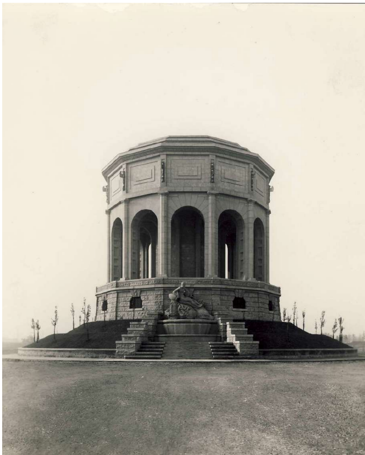
Acquedotto: serbatoio monumentale nel rione giardino
