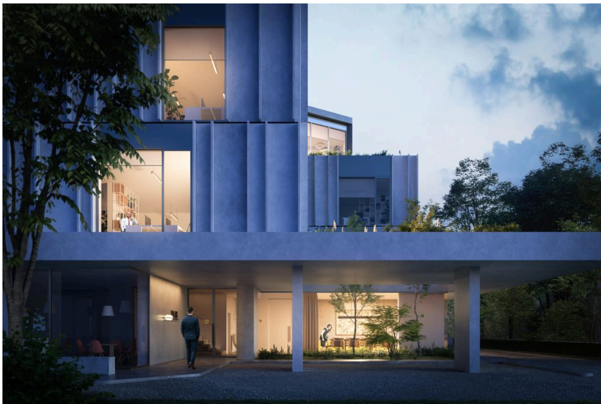
L'edificio crea un rapporto diretto tra l'interno e l'esterno, consentendo la percezione del verde a tutti i livelli
