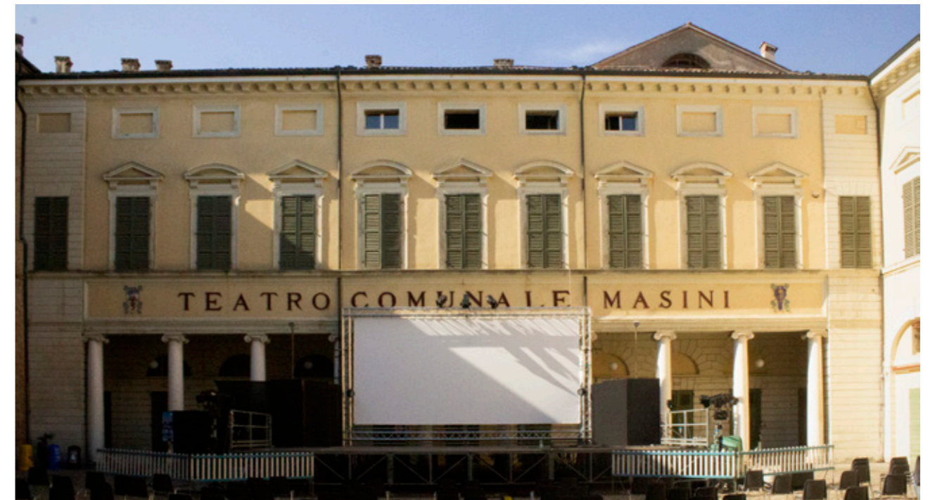
Fig. 72 Theatre A. Masini di Faenza, main front in Piazza della Molinella. Photographic survey dated September 2021. Ph. M. Suppa.
