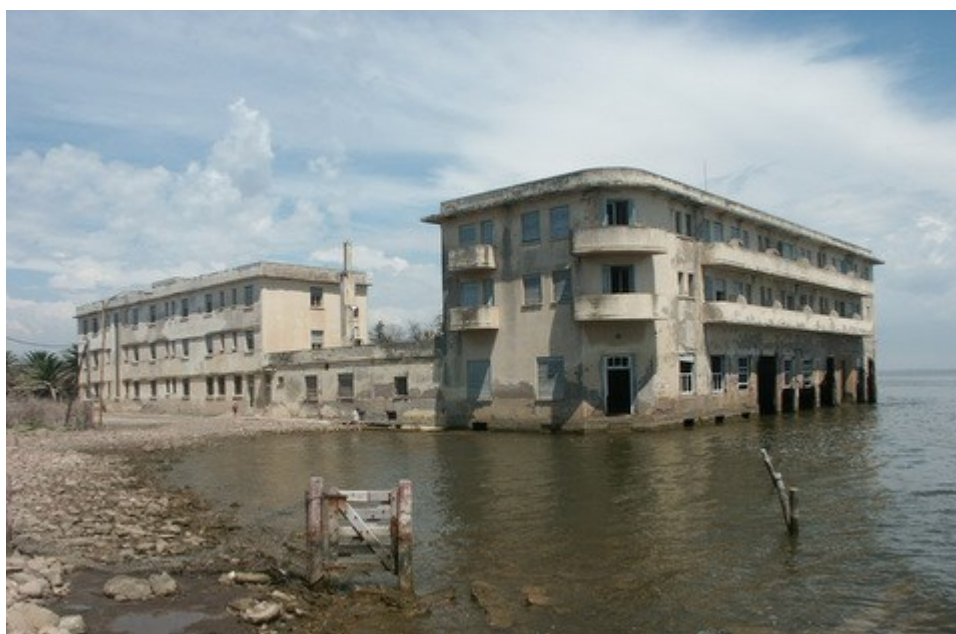
Imagen 23. Ruinas del Hotel Viena en la inundación de 2003. Fuente: Blog Inundaciones y Ambiente (Consultado diciembre 2015).
