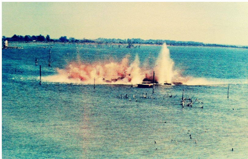
Imagen 16. Primera demolición controlada en Miramar.
