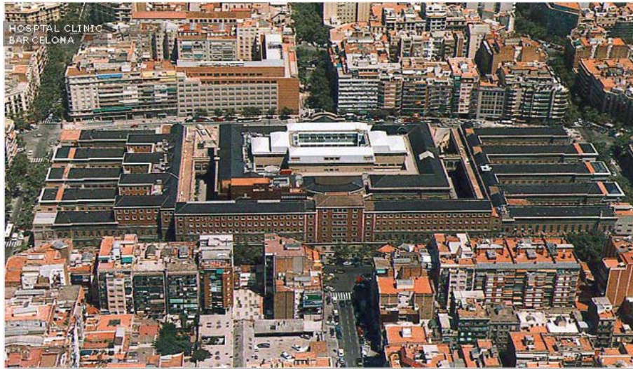
Figure 10. Aerial view of the Hospital Clinic, Antiga Esquerra de l'Eixample, Barcelona.
